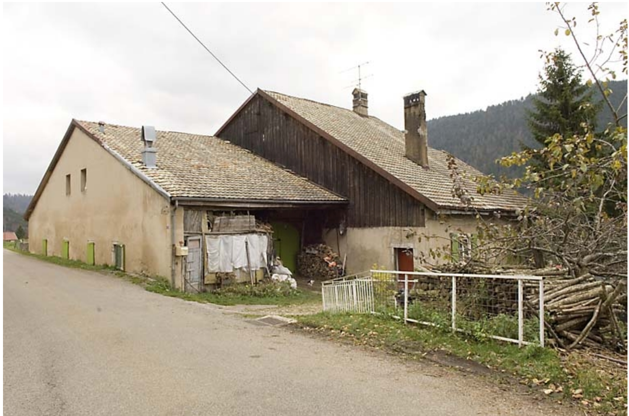
Façades sud et ouest.
