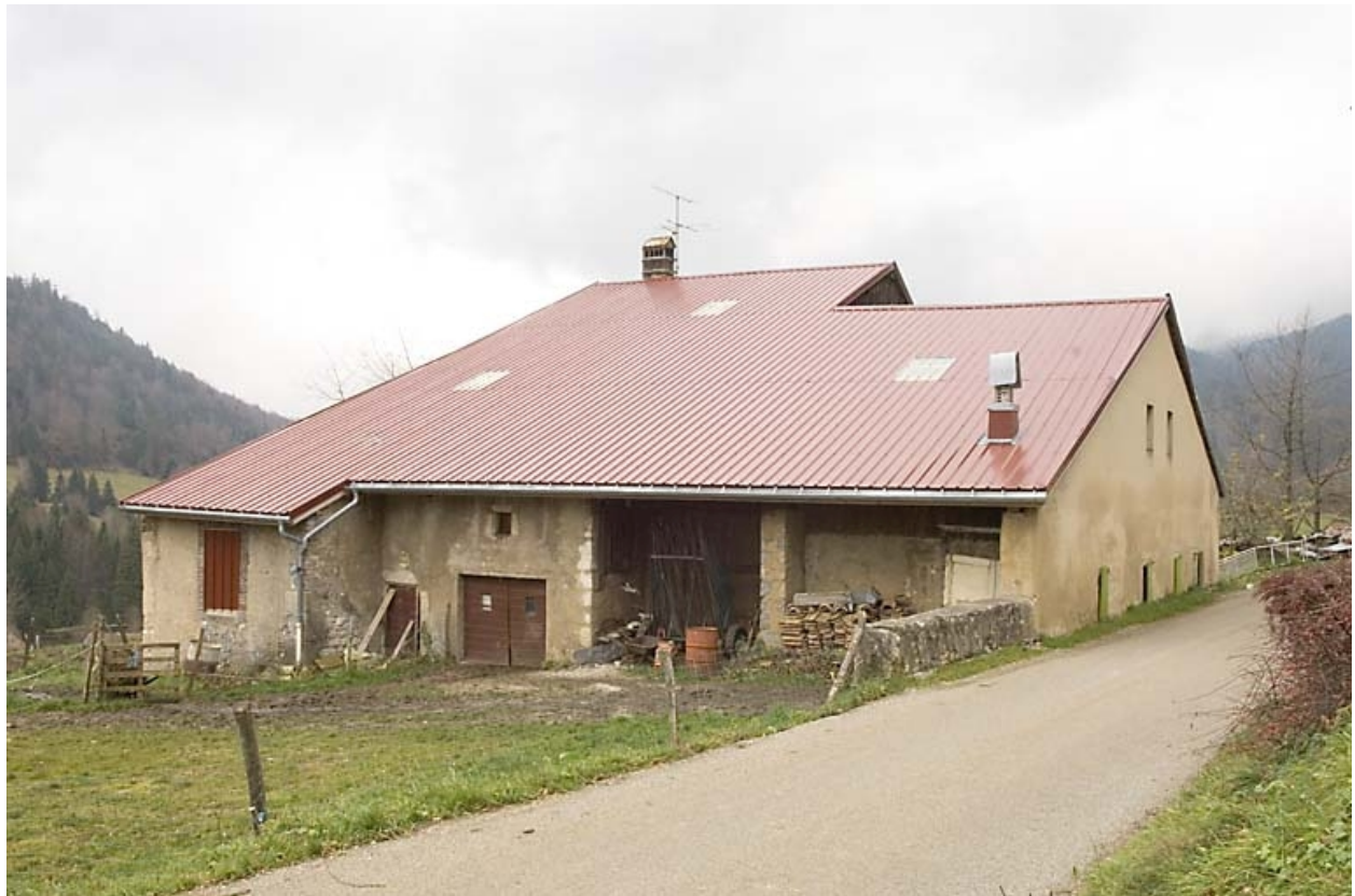
Façades nord et ouest.
