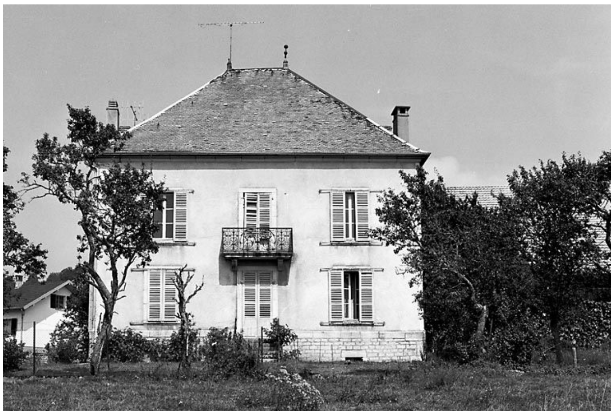
Façade postérieure du logis.
