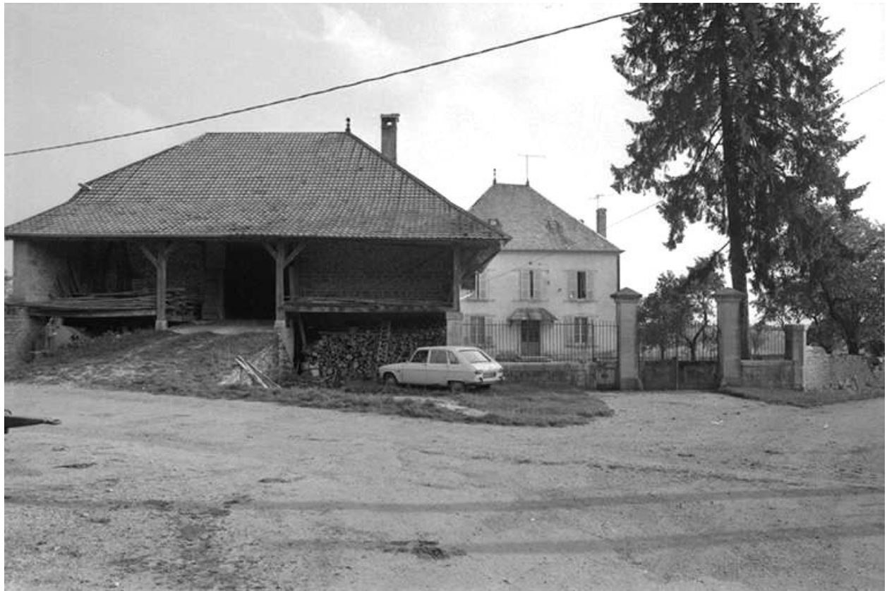
Vue d'ensemble depuis la rue.
