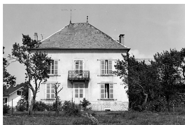
Façade postérieure du logis. Phot. Yves Sancey IVR43_19802501051X
