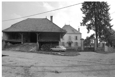
Vue d'ensemble depuis la rue. Phot. Gilbert Poinot IVR43_19762500927Z
