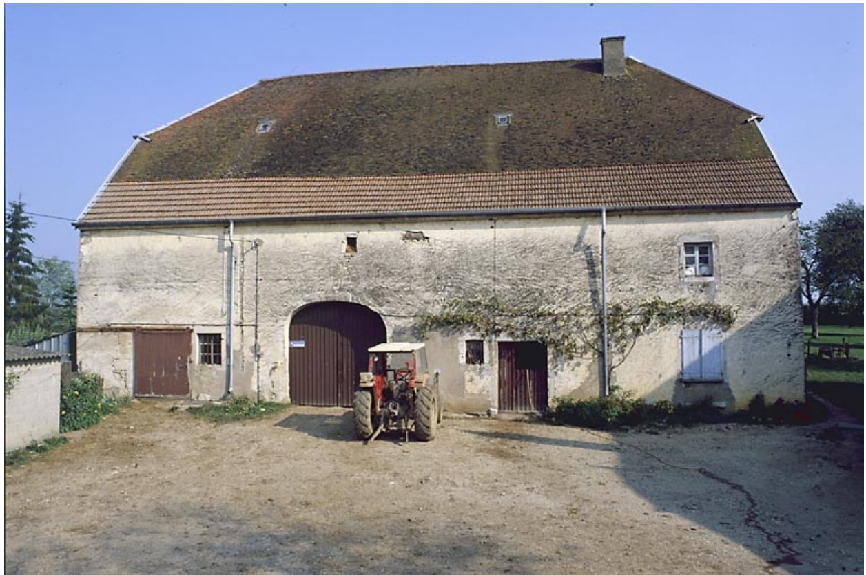
Ferme située rue de la Mairie : façade sur cour.
