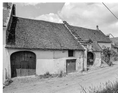
Ferme située rue Chateraine : façade antérieure.
