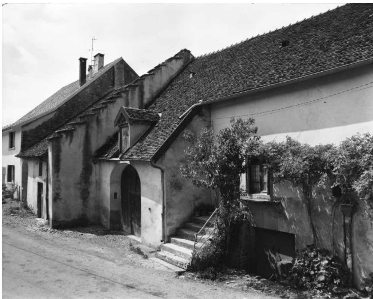
Ferme située rue Chateraine : façade antérieure.
