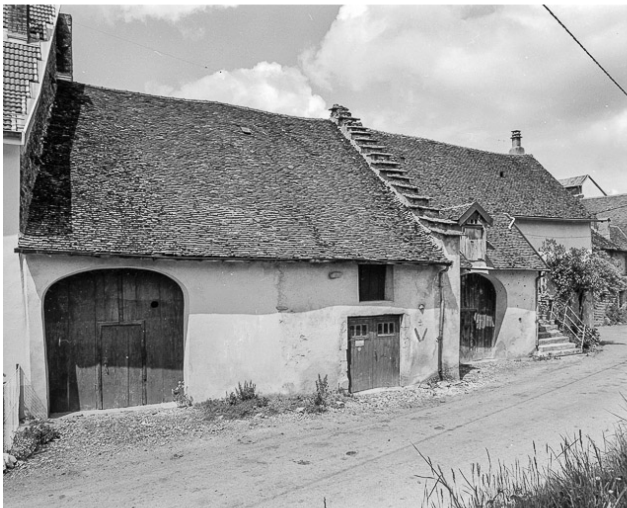
Ferme située rue Chateraine : façade antérieure.
