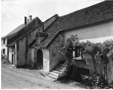
Ferme située rue Chateraine : façade antérieure. Phot. Yves Sancey IVR43_19813900194X
