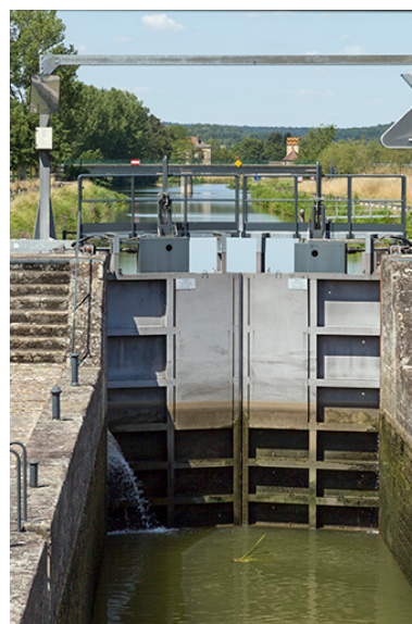
Le sas de l'écluse. Phot. Sonia Dourlot IVR43_20157000754NUC2A
