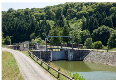
Vue d'ensemble. Phot. Sonia Dourlot IVR43_20157000750NUC2A
