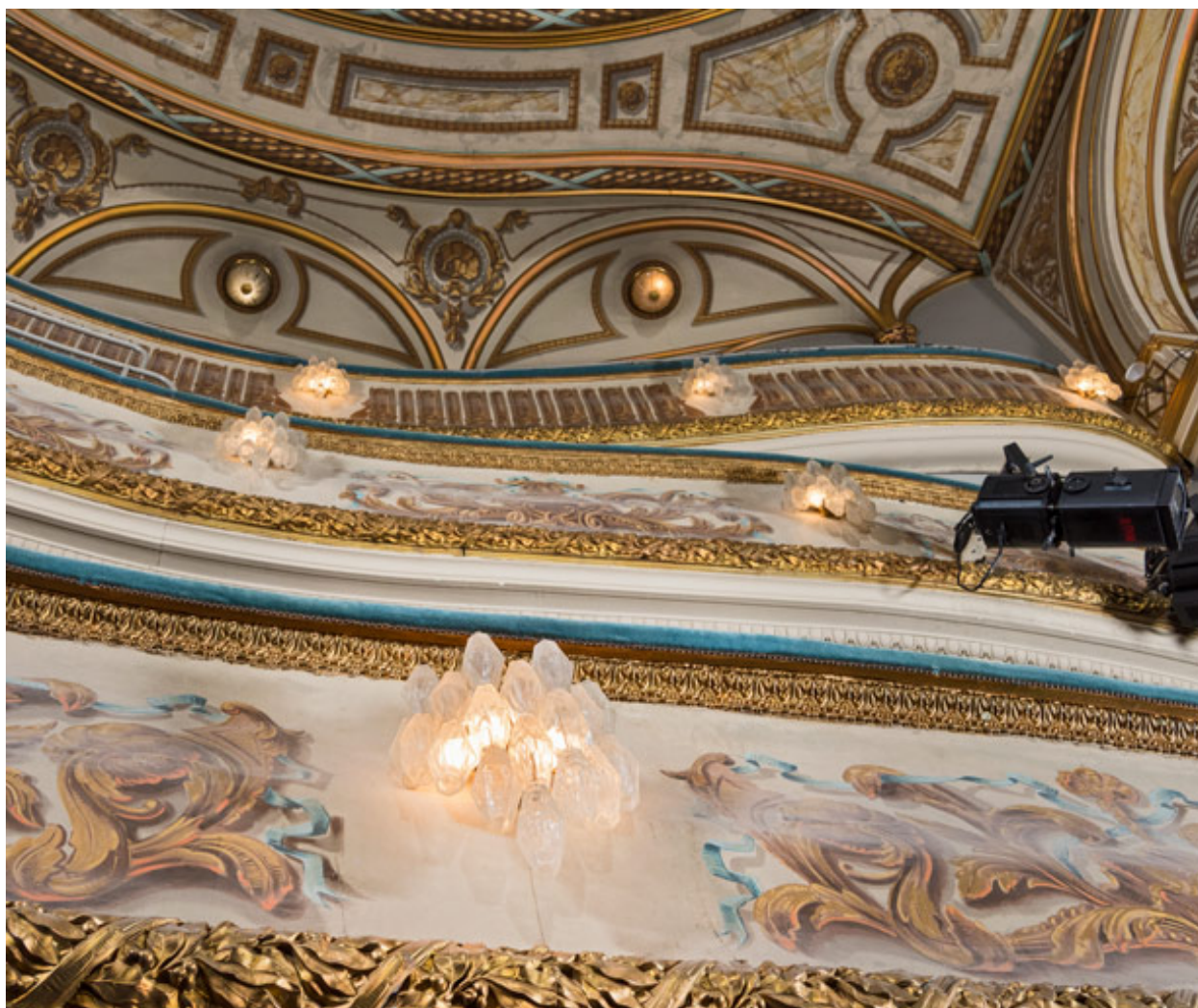
Luminaires d'applique sur les garde-corps des balcons.
