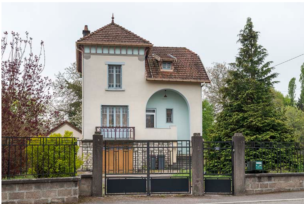
Vue générale depuis la rue du Tertre.
