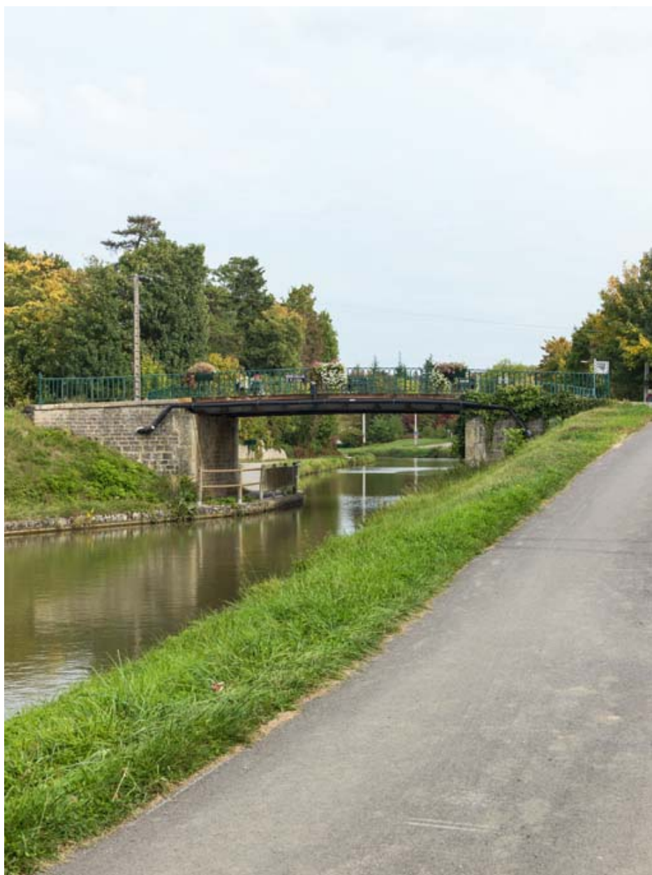
Vue d'ensemble du pont.
