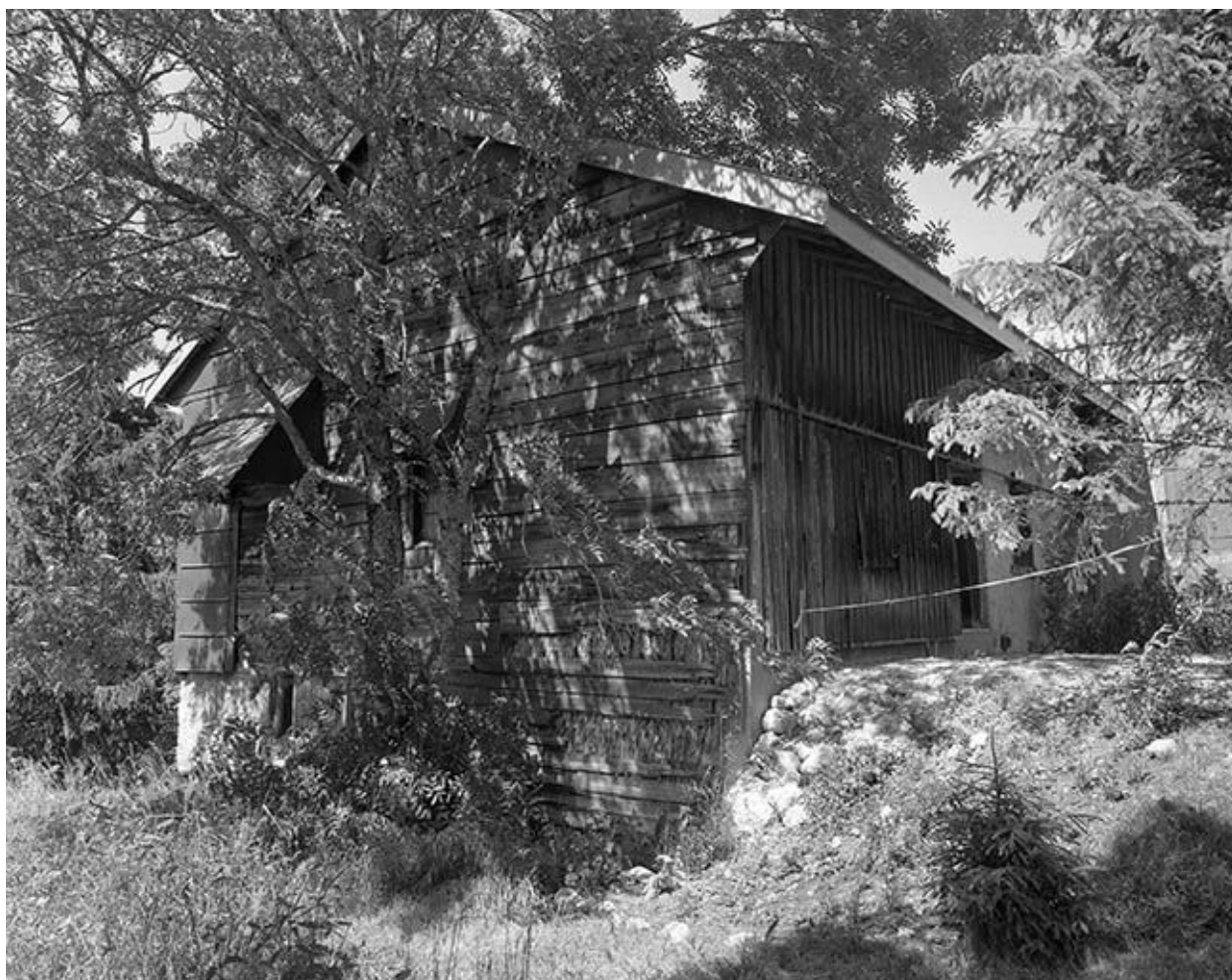
Le bâtiment abritant la scierie.
