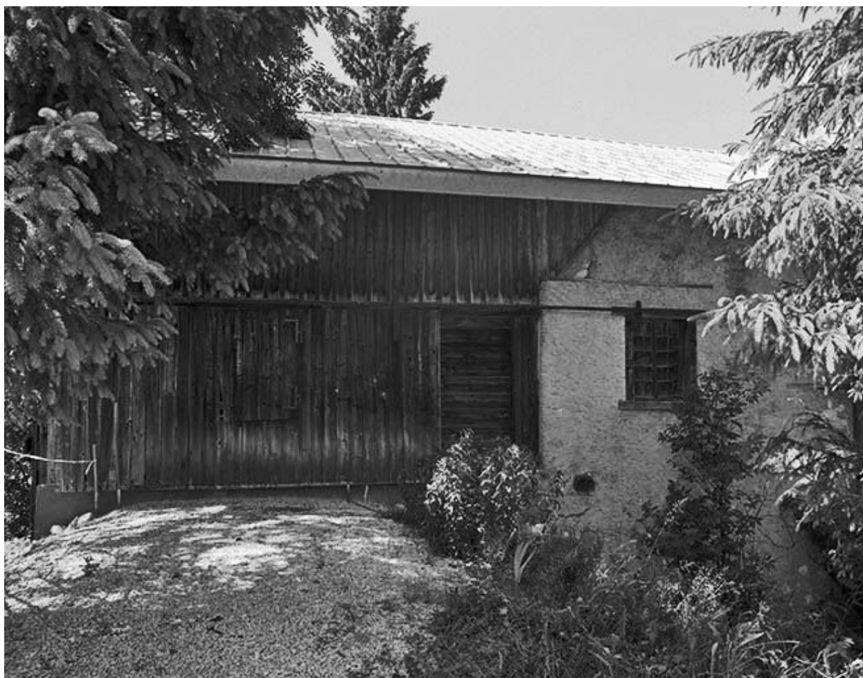
Façade antérieure du bâtiment abritant la scierie.
