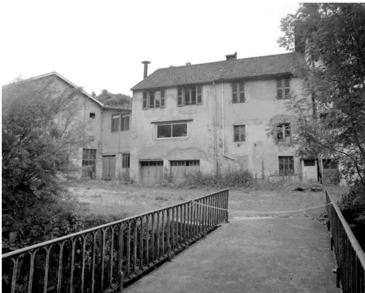
Façade postérieure du bureau et du logement.
