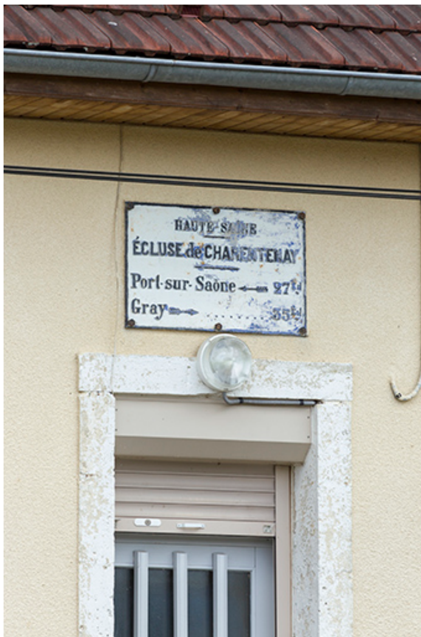
Plaque signalétique de l'écluse.
