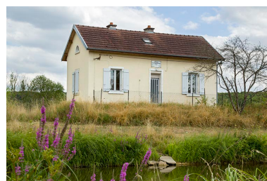
La maison d'éclusier. Phot. Sonia Dourlot IVR43_20157000830NUC2A
