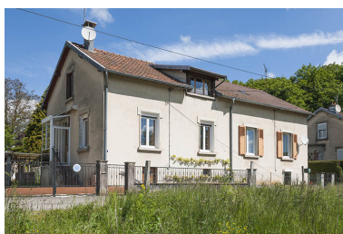
Maison ouvrière. Phot. Jérôme Mongreville IVR43_20132500421NUC4A
