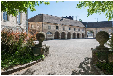
Cour d'externat avec entrée principale en arrière-plan. Phot. Jérôme Mongreville IVR43_20143900231NUC4A
