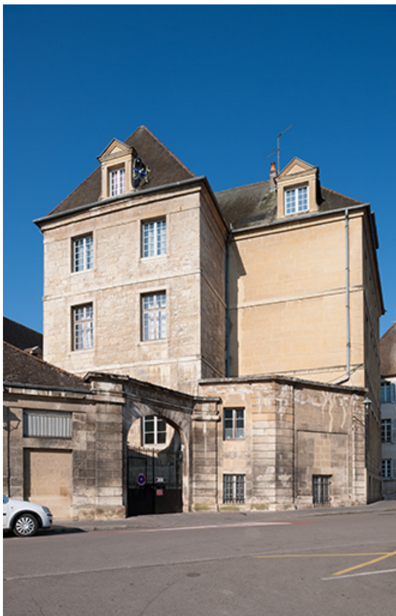
Façades des bâtiments d'externat, rue des Boucheries.
