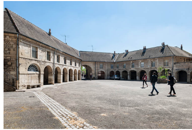
Cour d'externat avec entrée principale en arrière-plan. Phot. Jérôme Mongreville IVR43_20143900241NUC4A
