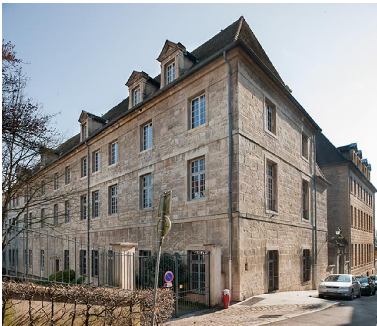
Façades des bâtiments d'externat, rue Bauzonnet.
