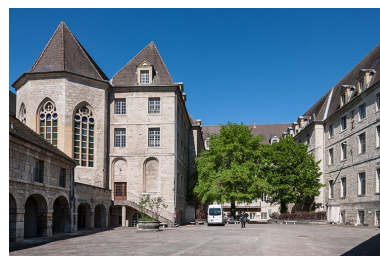
Chapelle du couvent des Dames d'Ounans, et façades des bâtiments logements (à gauche) et externat (à droite). Phot. Jérôme Mongreville IVR43_20143900229NUC4A
