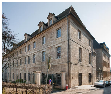
Façades des bâtiments d'externat, rue Bauzonnet. Phot. Jérôme Mongreville IVR43_20143900242NUC4A
