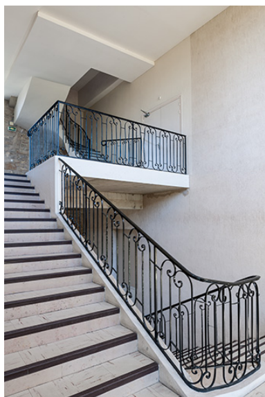
Internat, escalier intérieur. Phot. Jérôme Mongreville IVR43_20143900259NUC4A
