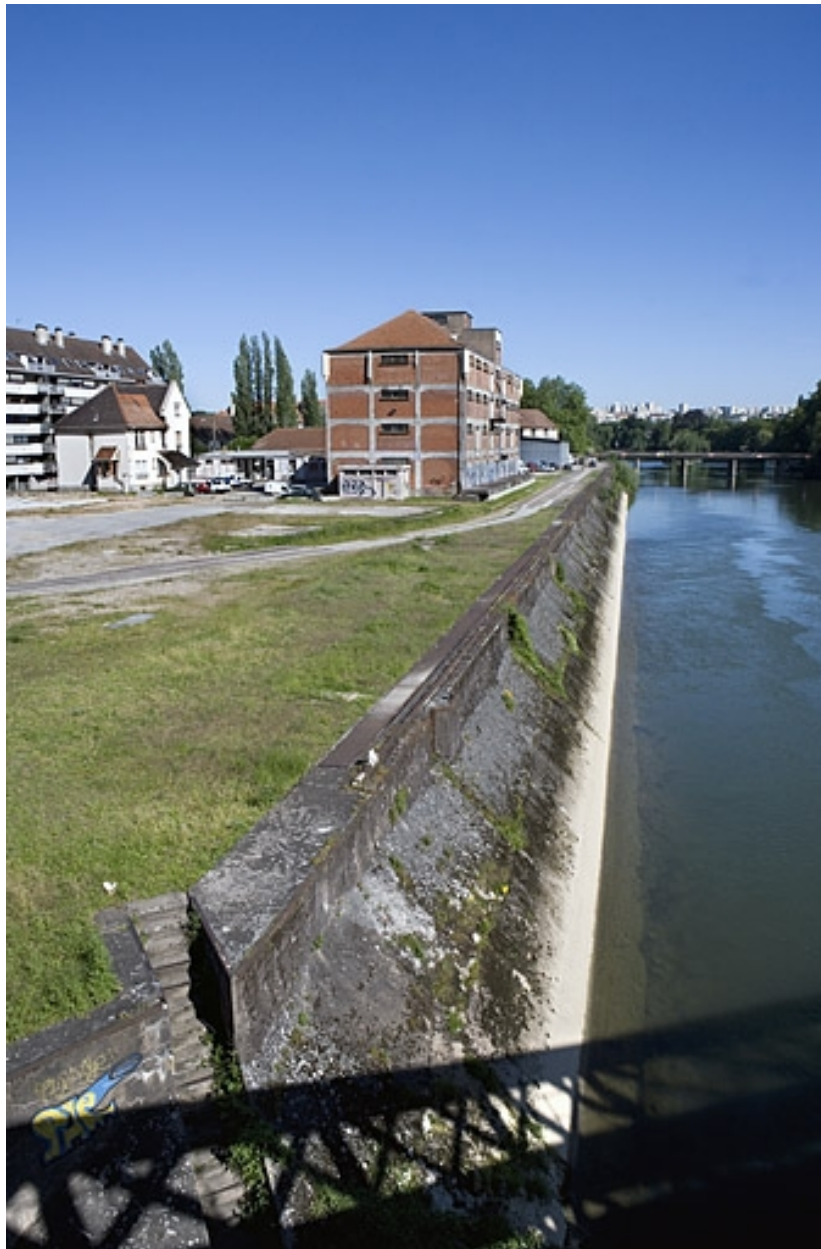
Entrepôt et quai, depuis l'amont.
