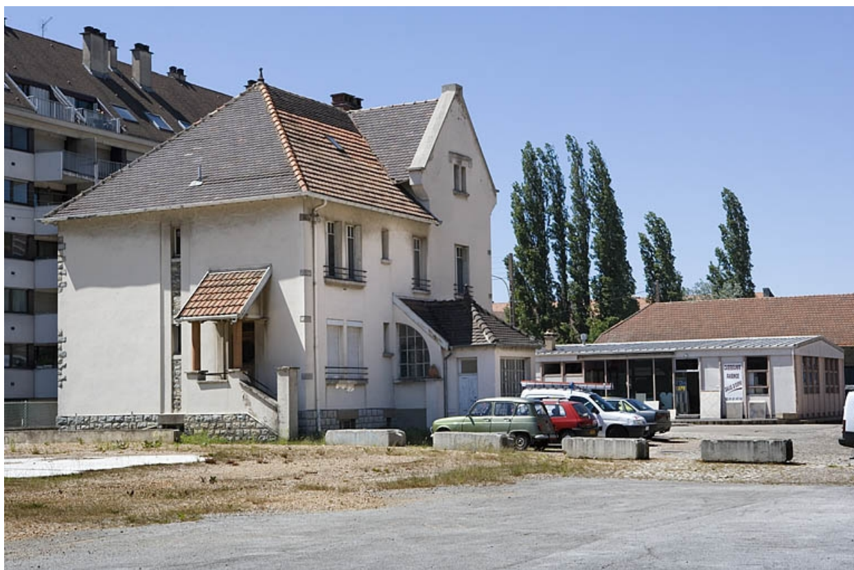
Bureau : façade postérieure de trois quarts gauche.
