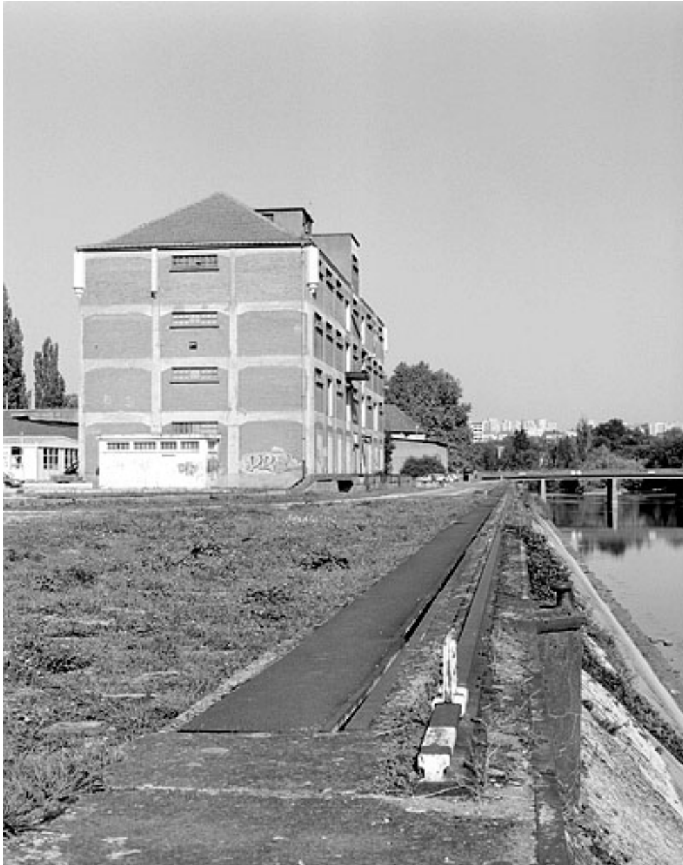
Entrepôt et quai, depuis l'amont (vue rapprochée)
