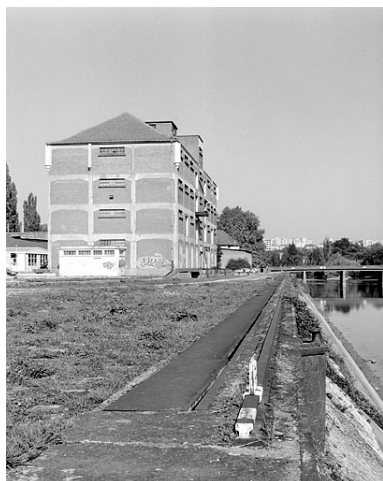
Entrepôt et quai, depuis l'amont (vue rapprochée) Phot. Jérôme Mongreville IVR43_20032500181X
