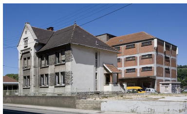
Bureau : façade antérieure de trois quarts droite. Phot. Yves Sancey IVR43_20062500193NUCA
