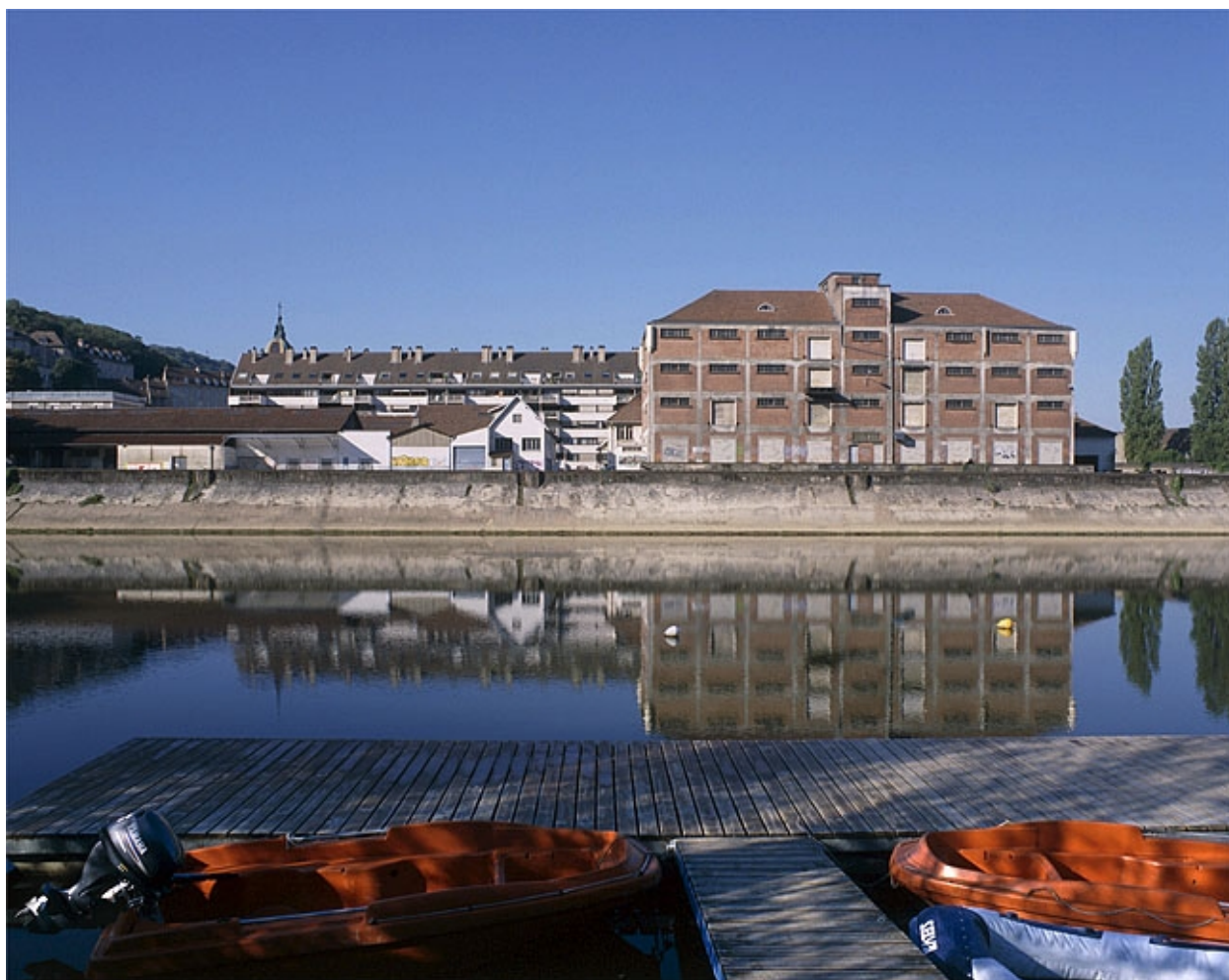
Vue d'ensemble depuis la rive droite, 2003.
