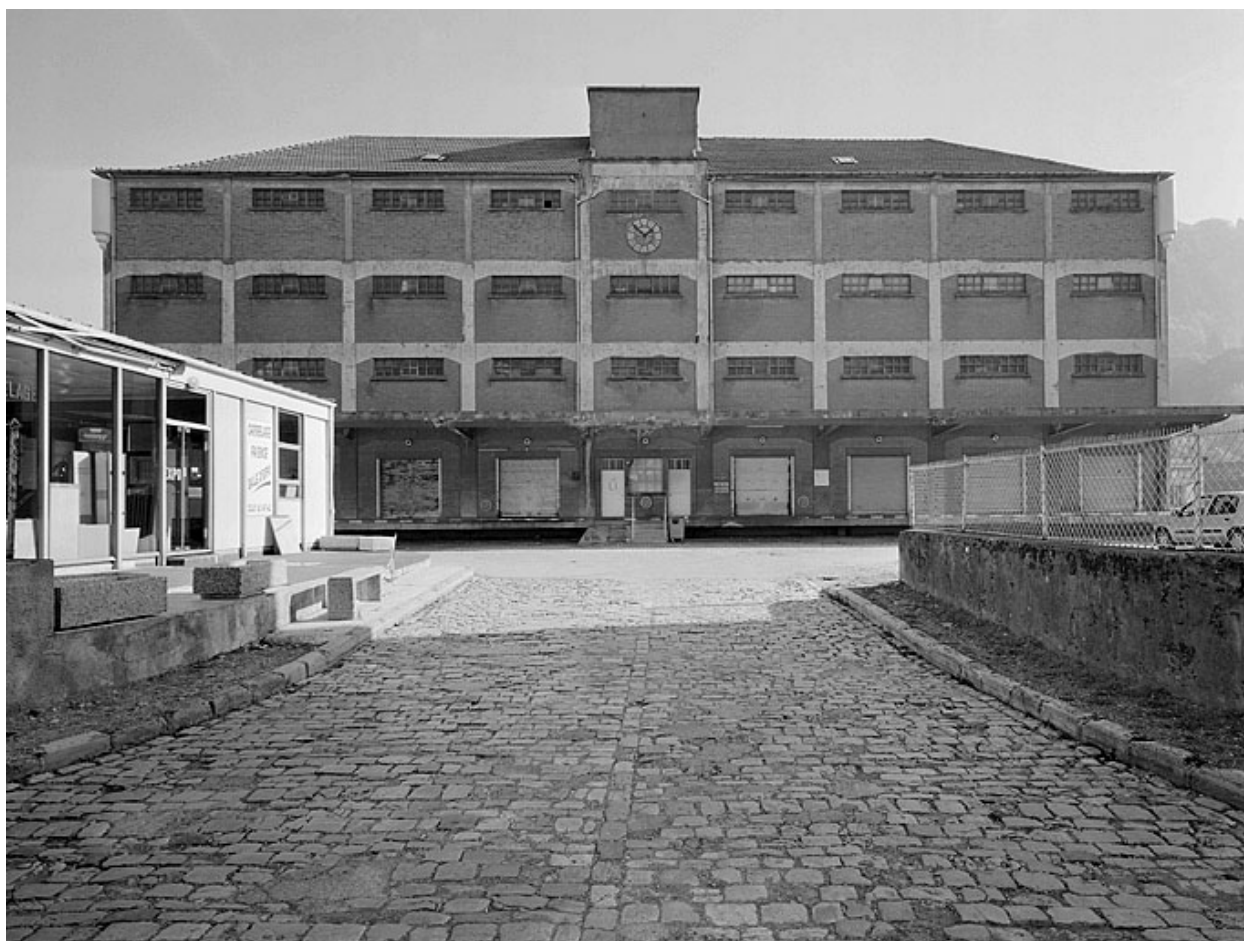
Entrepôt : façade antérieure.
