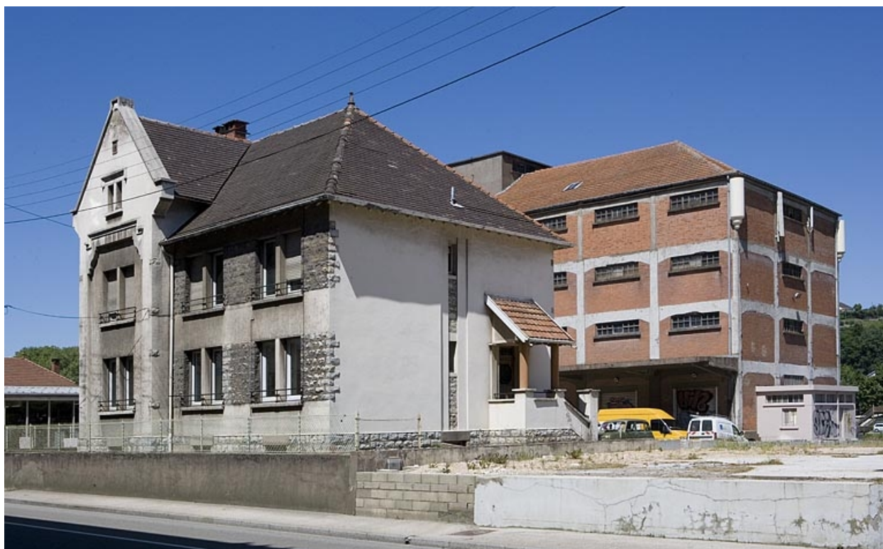
Bureau : façade antérieure de trois quarts droite.
