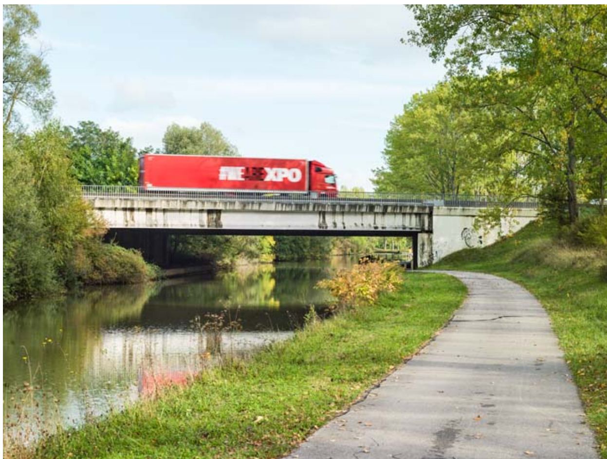
Vue d'ensemble du pont.
