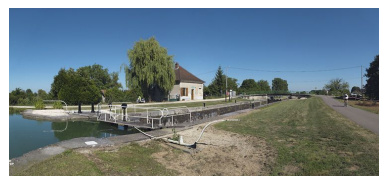
Vue d'amont. Phot. Thierry Kuntz IVR26_20112103033NUC4A
