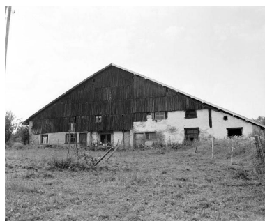
Ferme située au lieudit A la Cloison. Phot. Yves Sancey IVR43_19782500189X
