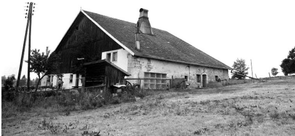
Façade antérieure et latérale droite.
