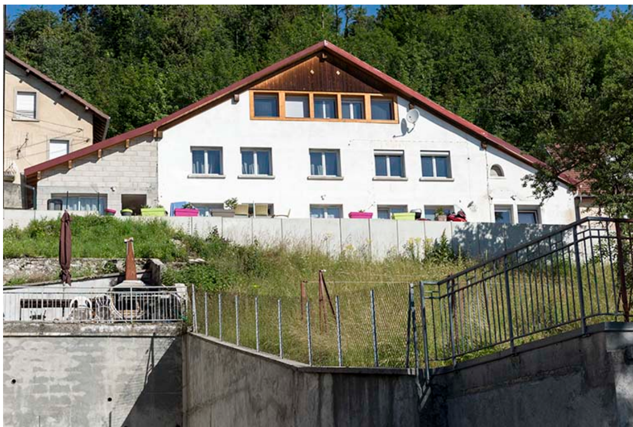
Façade est, vue en contre-plongée.
