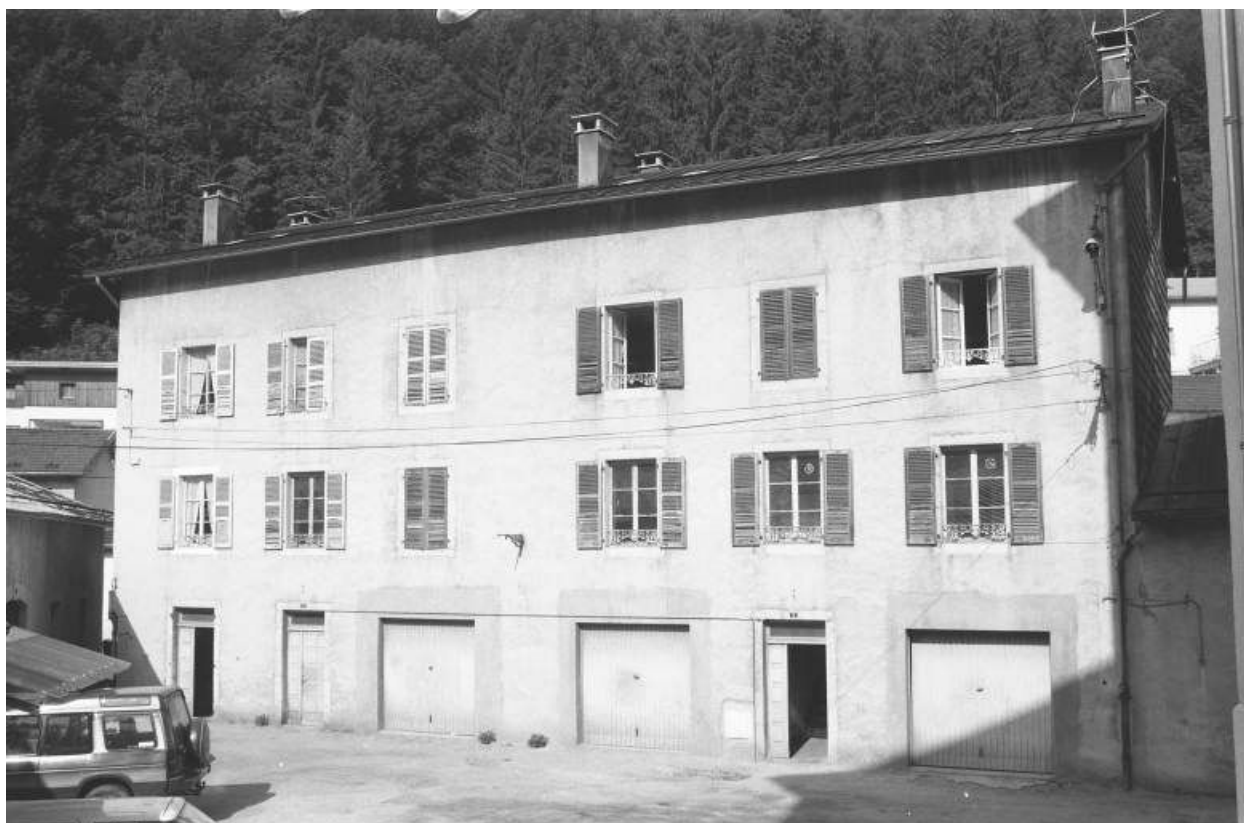
Immeuble et remise : façade sur la cour.
