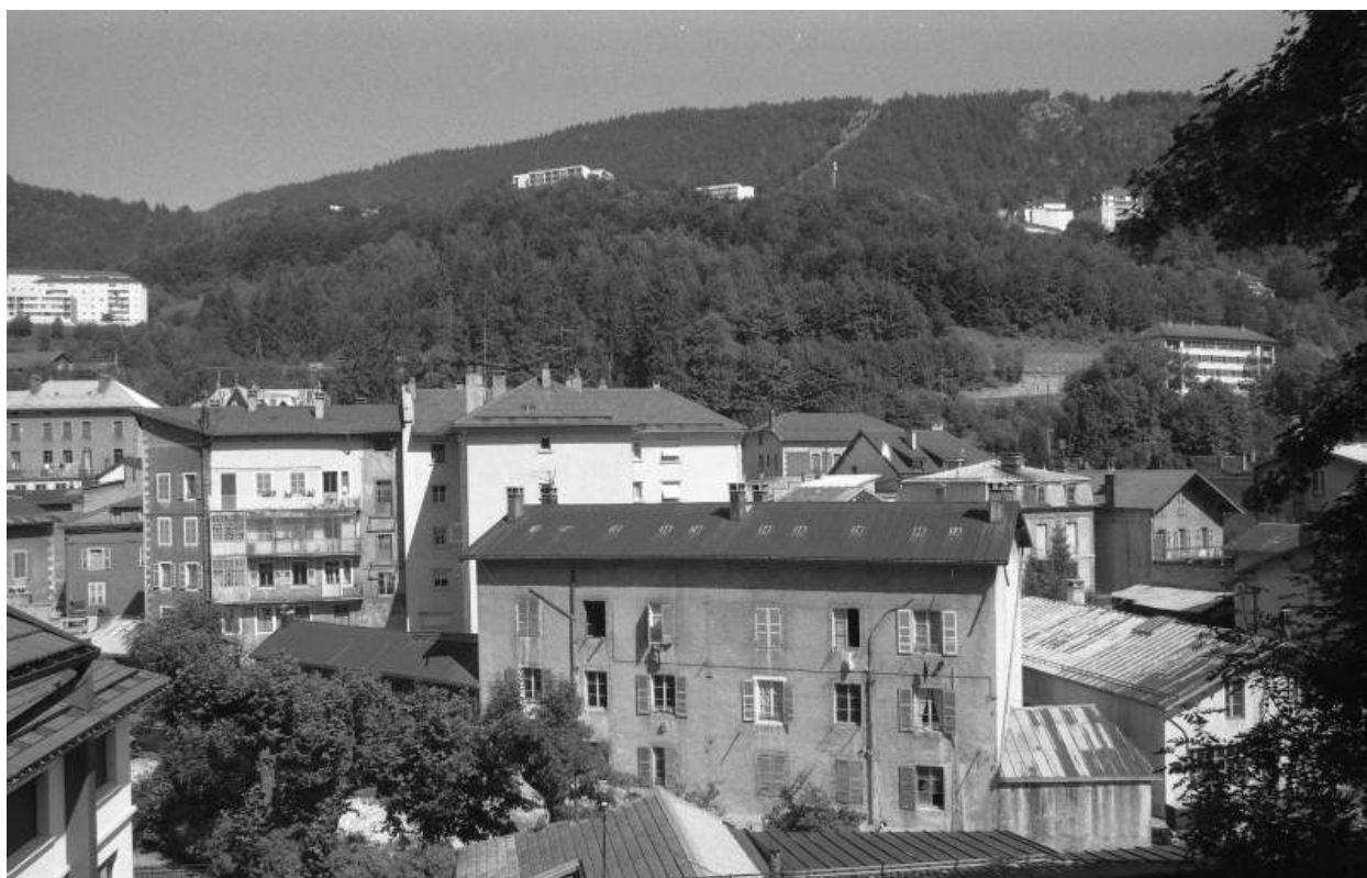
Immeuble et remise : façade sur la Bienne.
