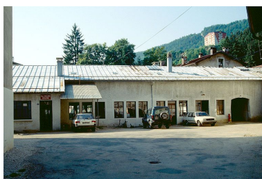
Atelier de fabrication dans la cour. Phot. Laurent Poupard IVR43_19913901543ZA
