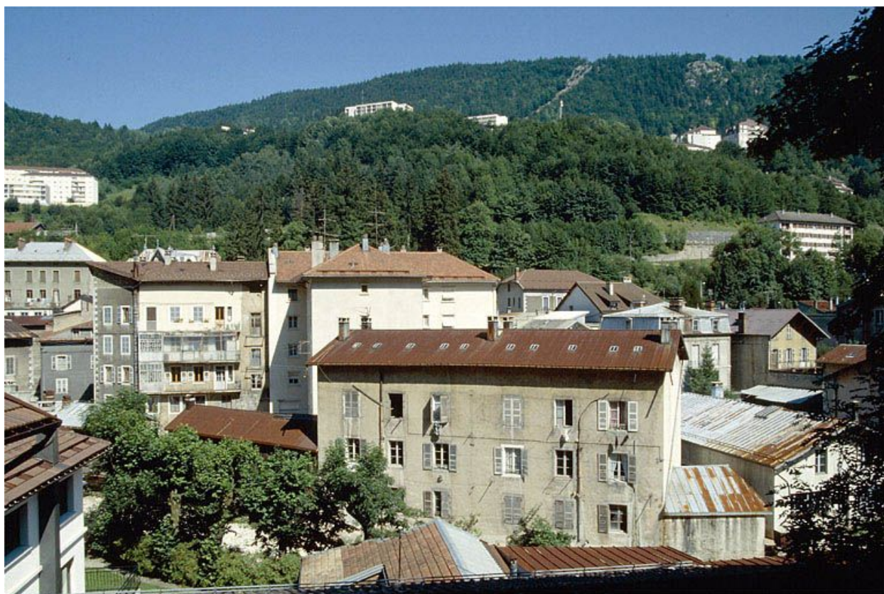
Immeuble et remise : façade sur la Bienne.
