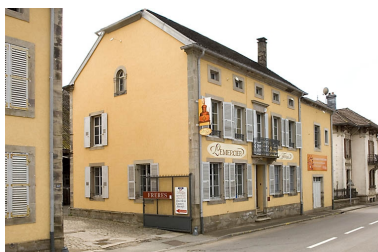
Bureaux et logement. Phot. Jérôme Mongreville IVR43_20077000248NUCA
