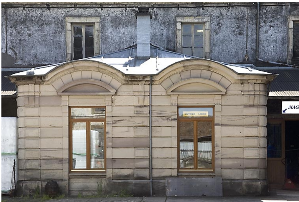
Bureaux. Mur sud de la cour.
