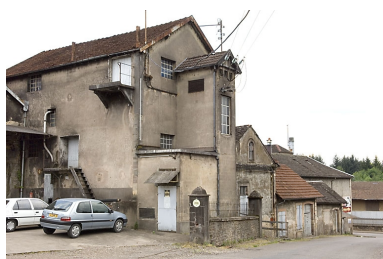
Façades sur la rue des Moines Hauts. Phot. Jérôme Mongreville IVR43_20077000245NUCA
