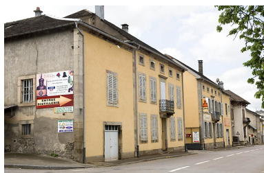
Bâtiments sur la rue de la Gare. Phot. Jérôme Mongreville IVR43_20077000246NUCA
