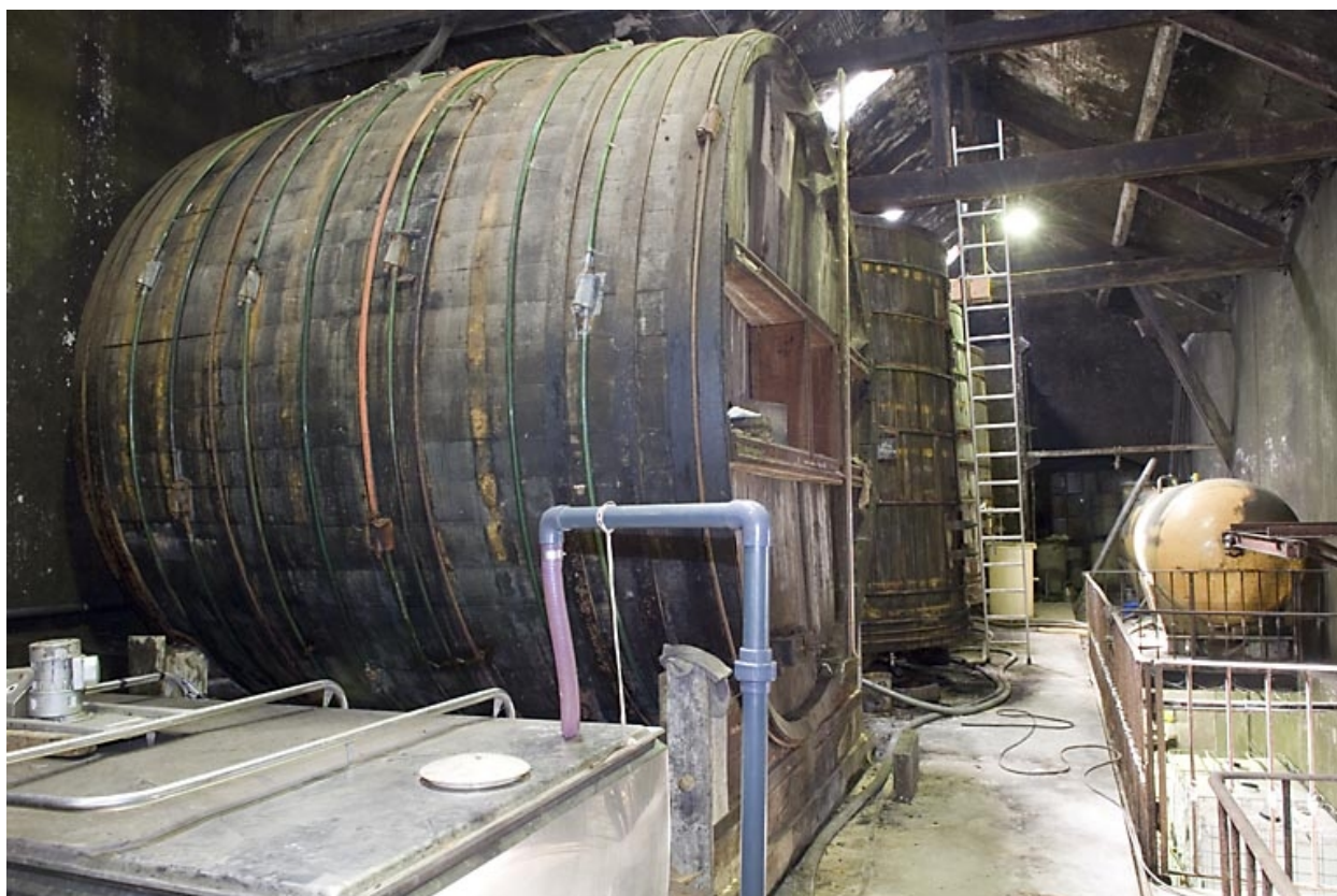
Etage de la cuverie. Foudres.
