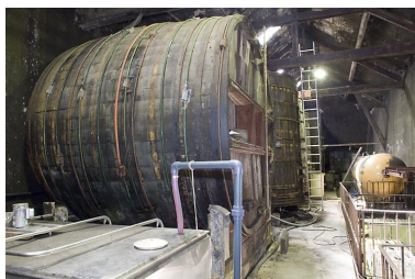
Etage de la cuverie. Foudres. Phot. Jérôme Mongreville IVR43_20077000258NUCA
