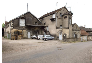
Ancienne écurie et cuvier. Vue depuis l'est. Phot. Jérôme Mongreville IVR43_20077000244NUCA
