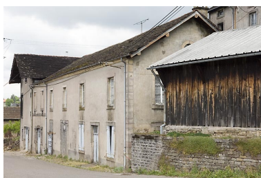
La menuiserie. Vue depuis le sud. Phot. Jérôme Mongreville IVR43_20077000241NUCA
