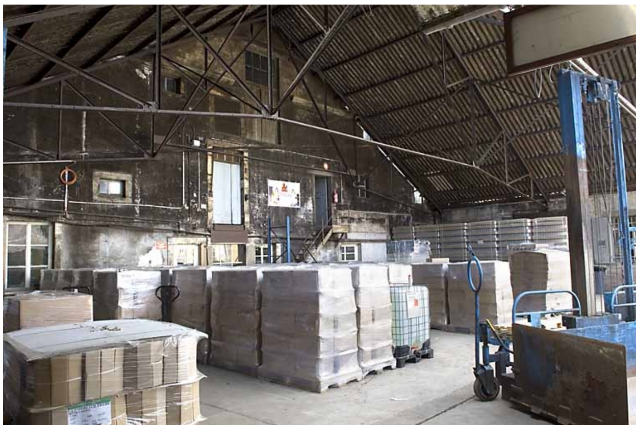
Partie couverte (ouest) de la cour.
