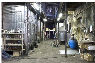
Cuverie. Installations récentes. Phot. Jérôme Mongreville IVR43_20077000253NUCA
