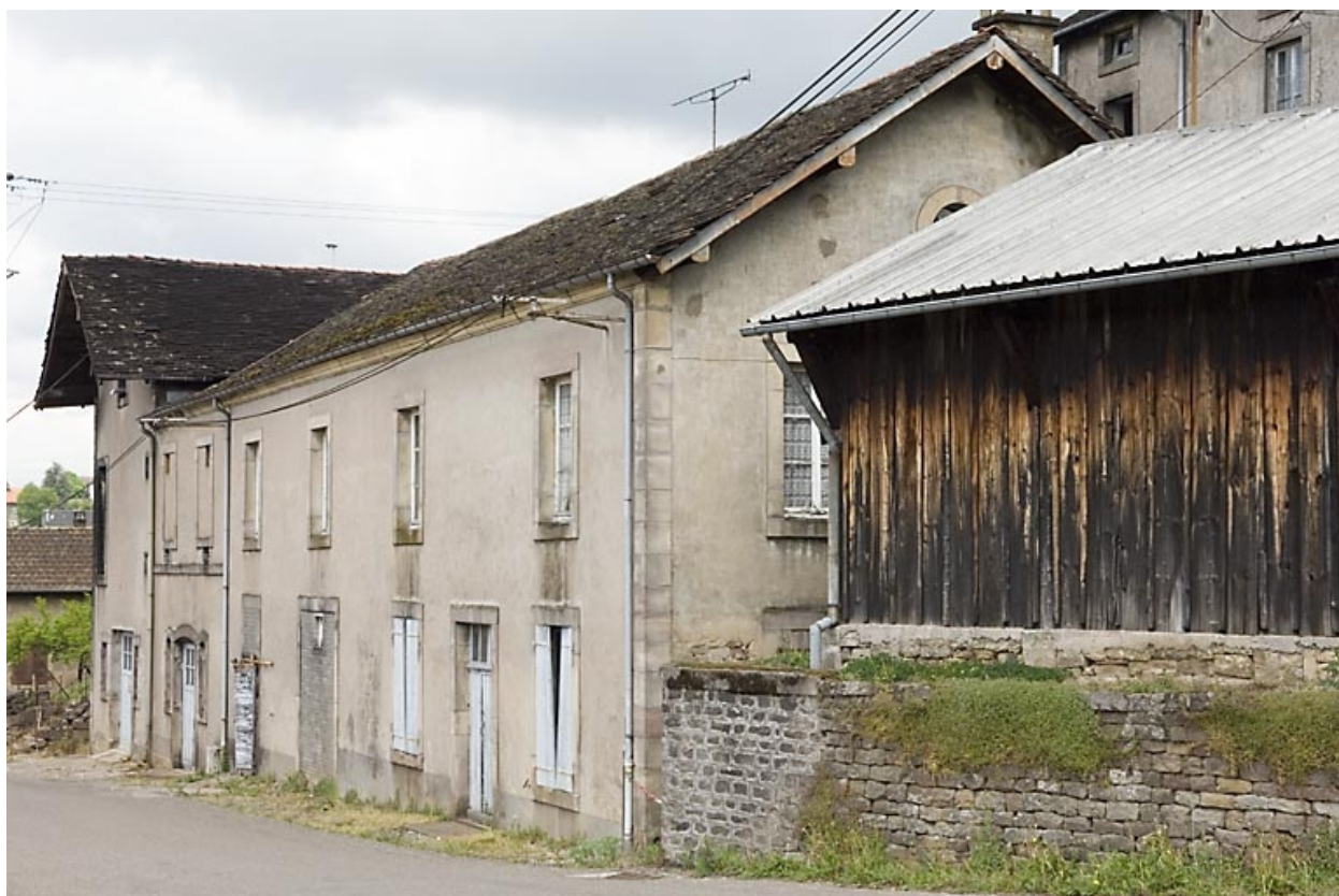
La menuiserie. Vue depuis le sud.
