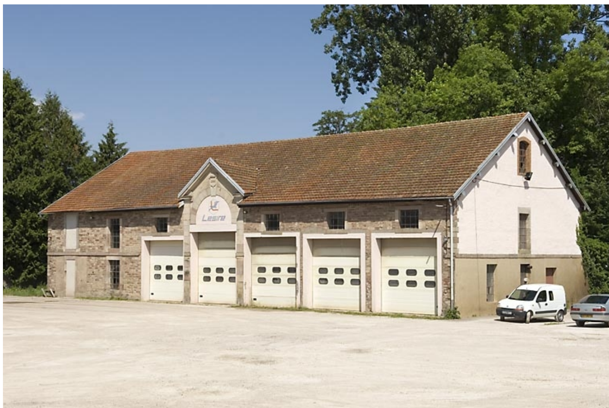
Atelier de fabrication. Vue de trois quarts.
