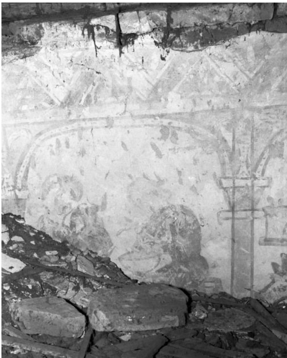
Comble de la nef, mur droit
