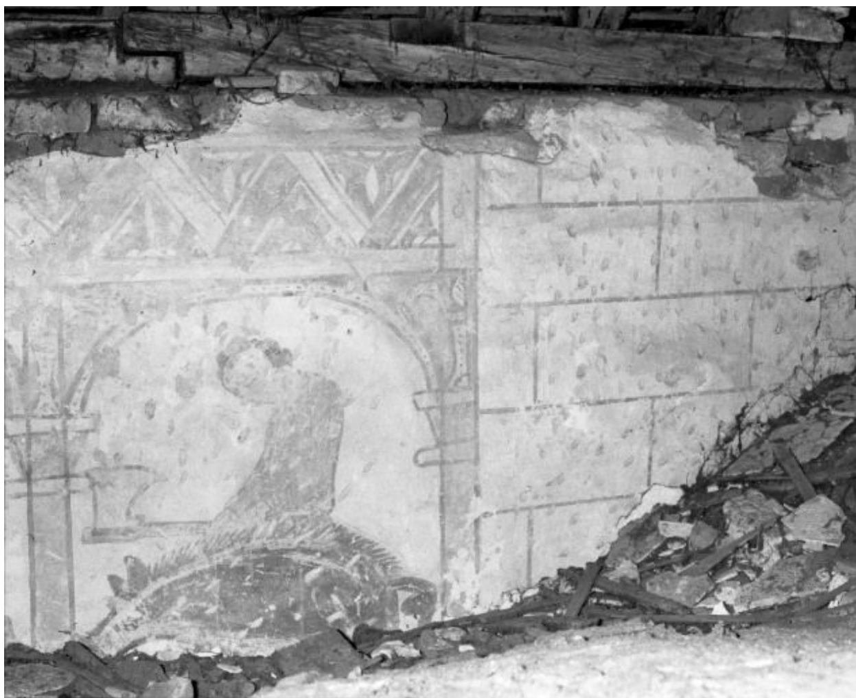
Comble de la nef, mur droit : décembre
