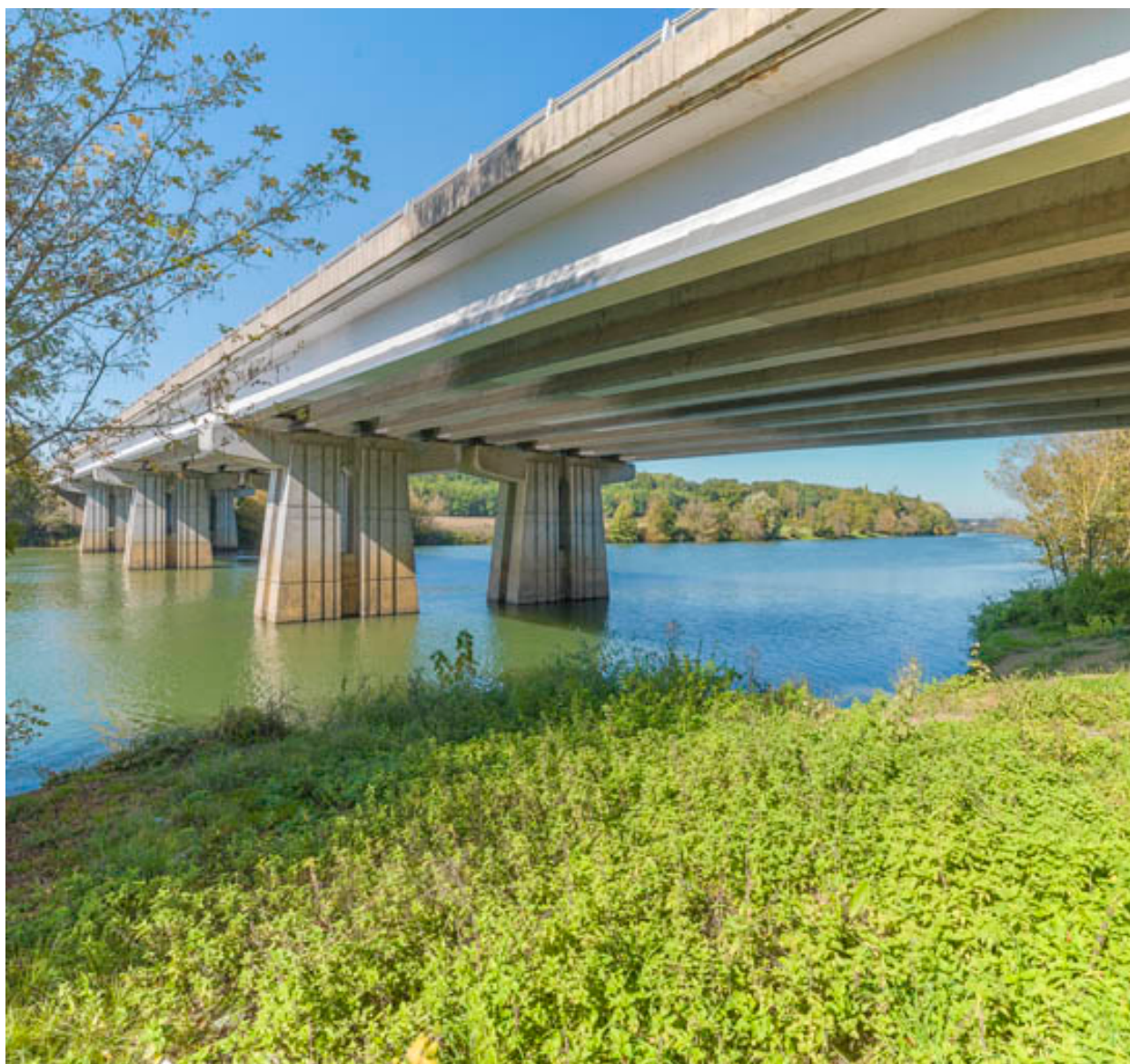
Vue rapprochée des piles et du tablier.
