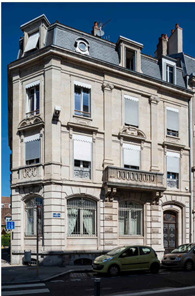
Façade sur la rue Gambetta (n°17).
