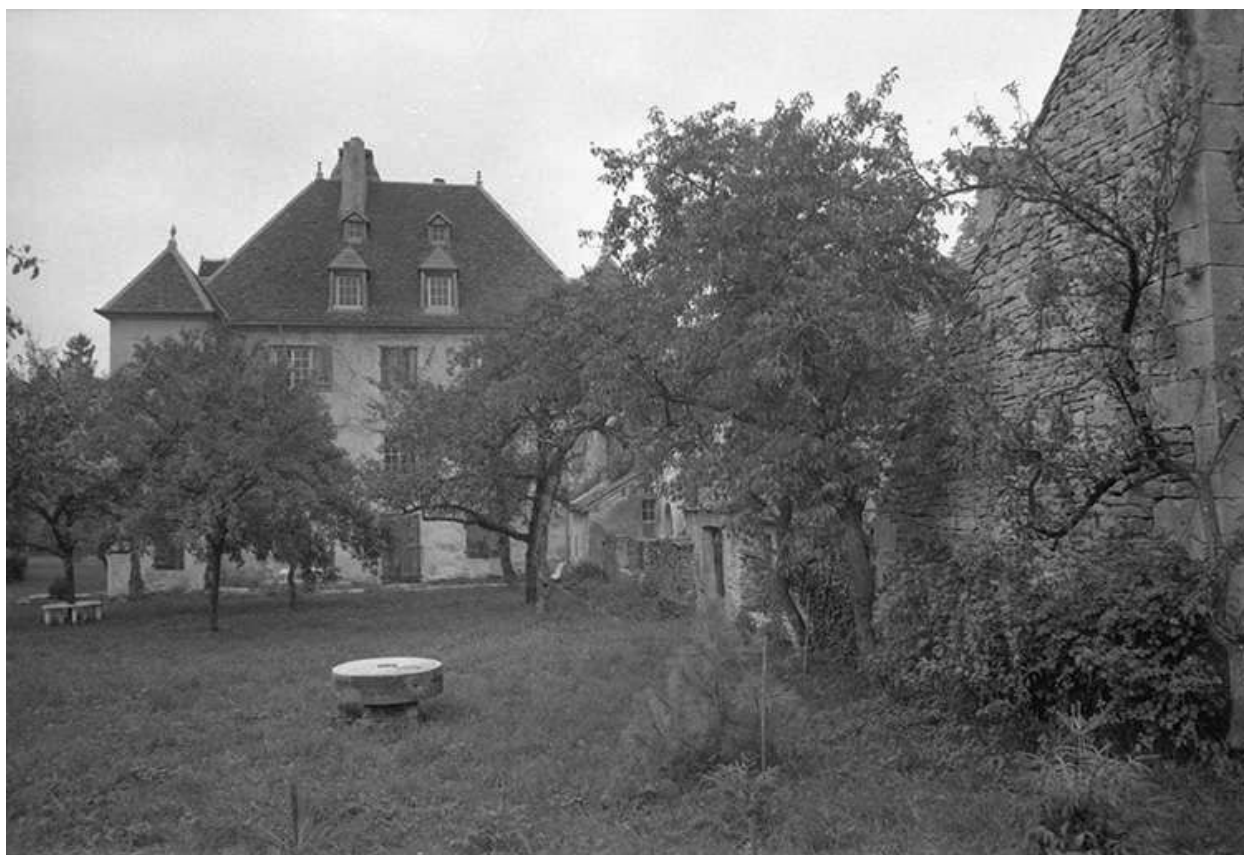
Face latérale droite vue depuis le parc.
