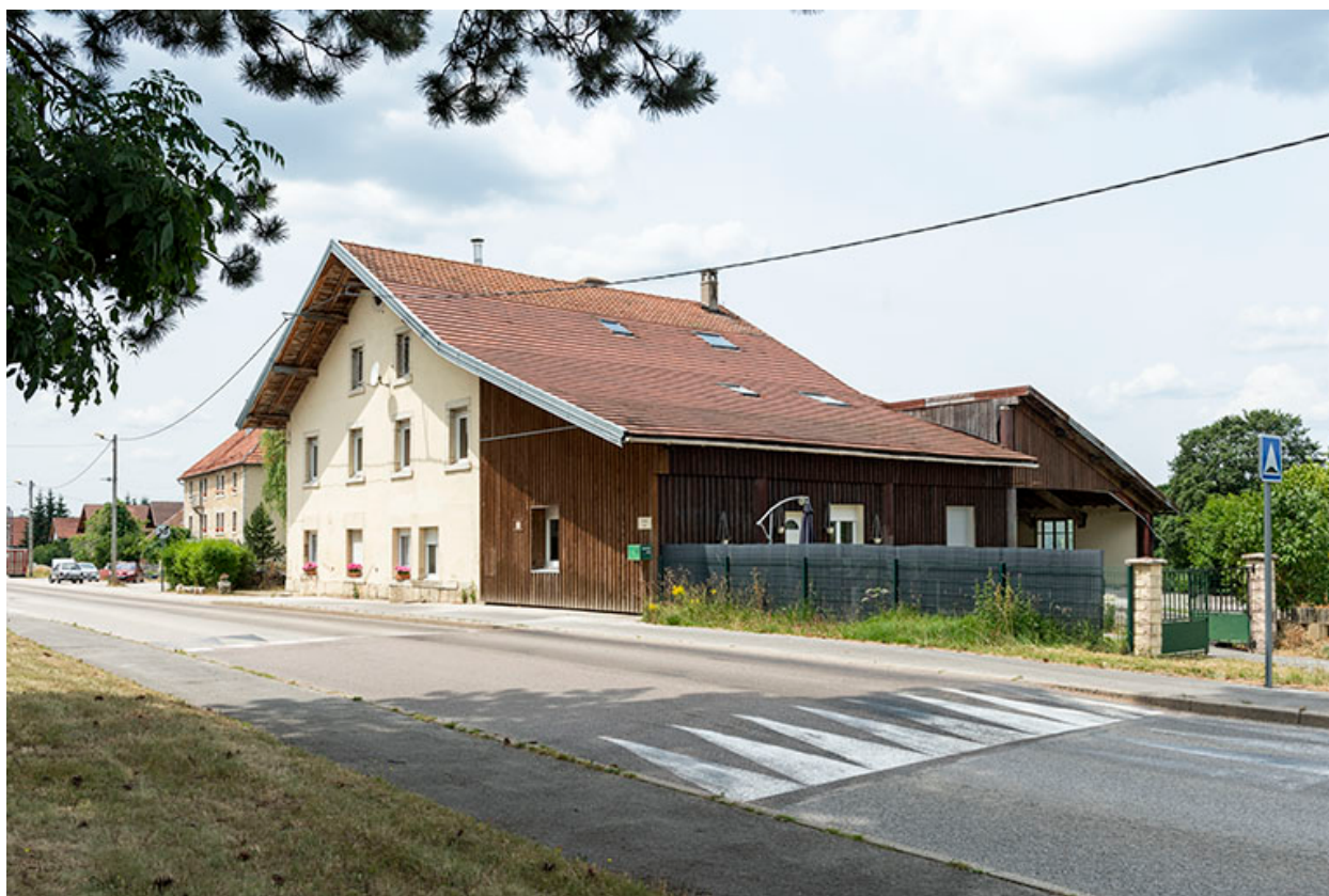
Façades antérieure et latérale droite.
