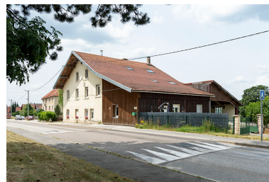
Façades antérieure et latérale droite.
