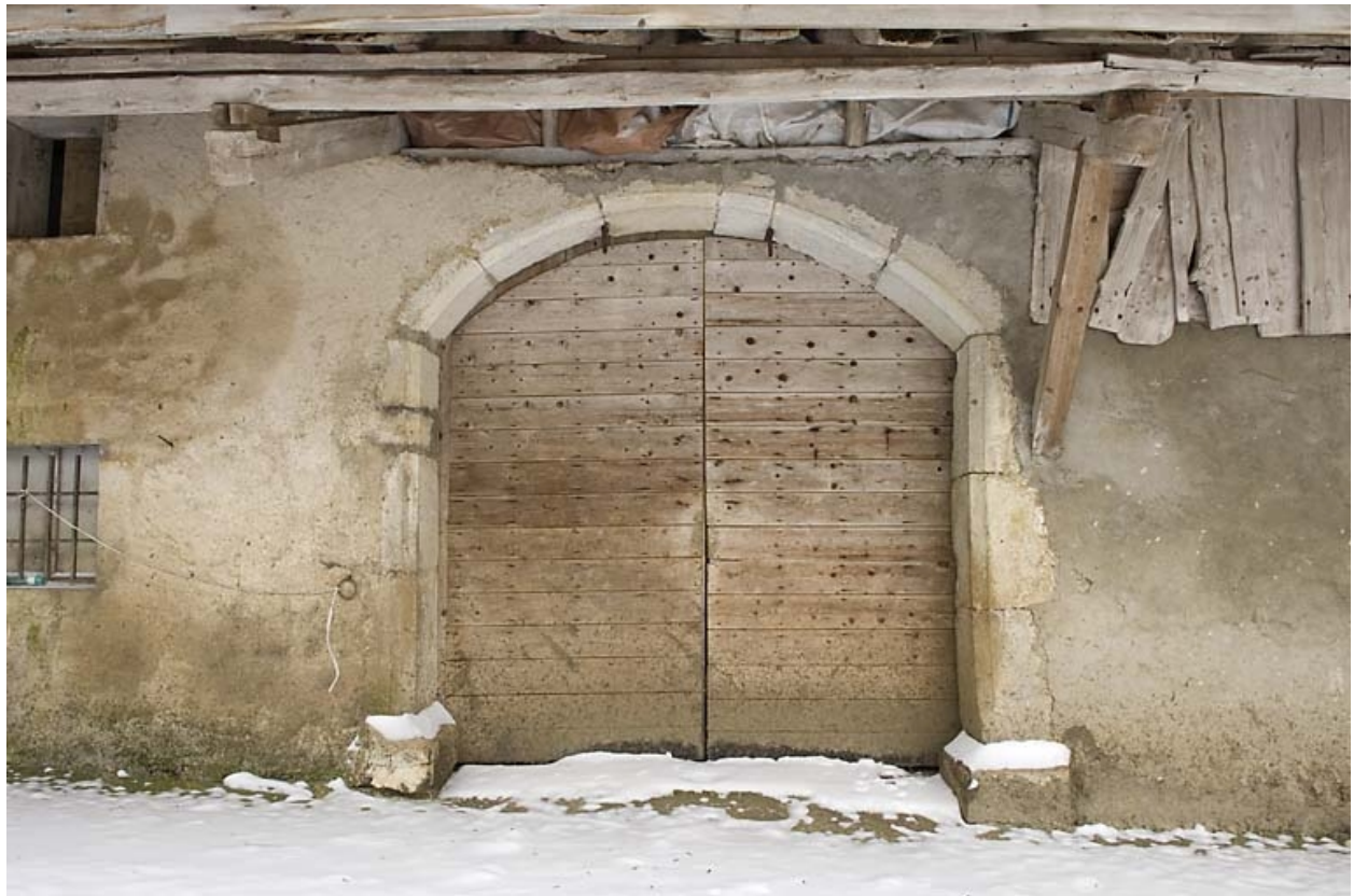
Façade postérieure : porte de grange.
