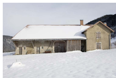
Façade antérieure, en hiver. Phot. Jérôme Mongreville IVR43_20082500973NUC2A
