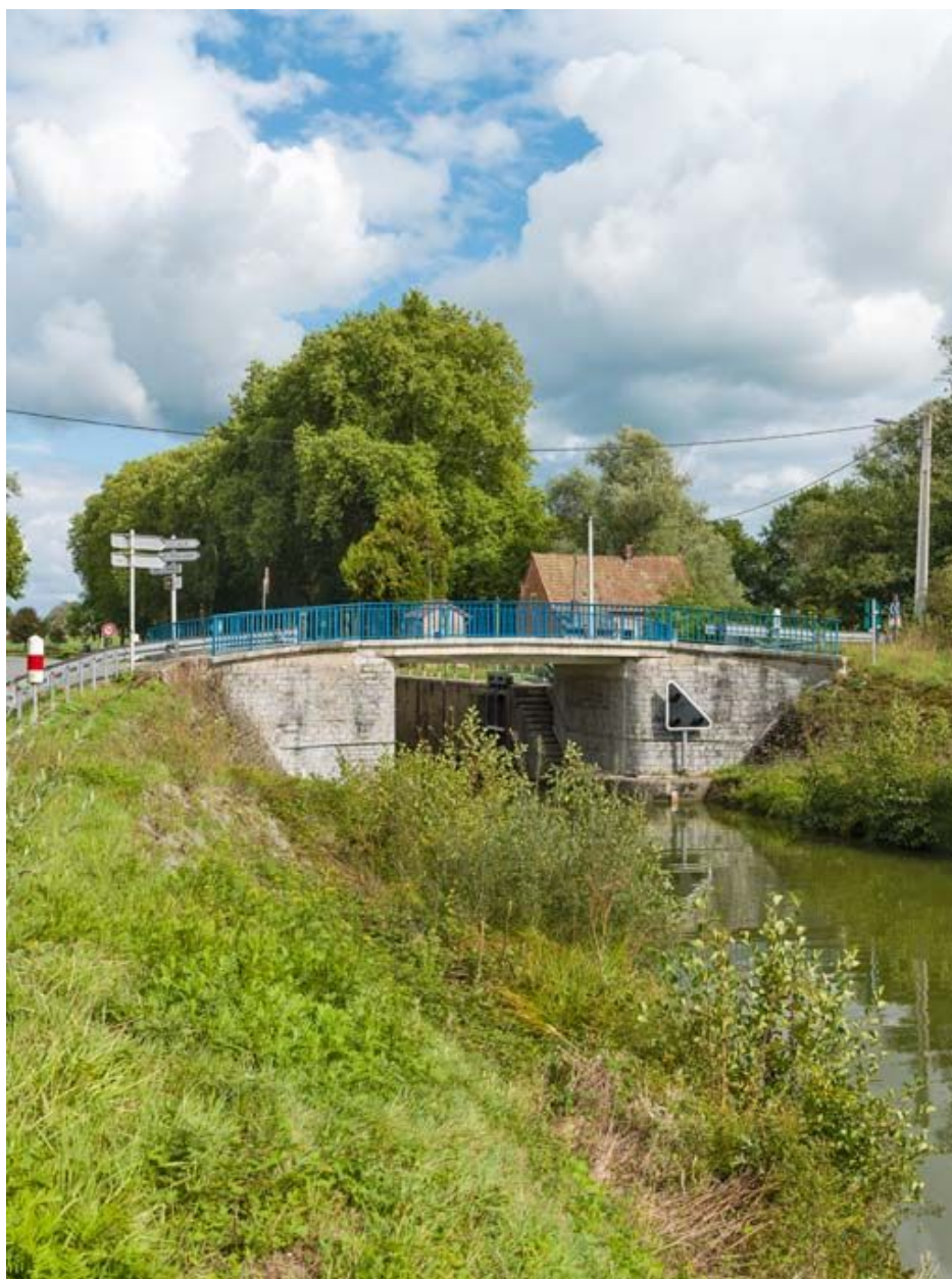
Vue d'ensemble du pont.
