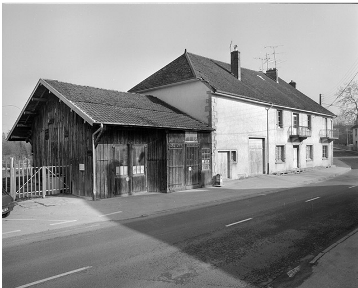
Remise à automobile et logement.
