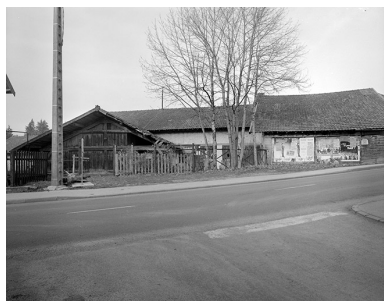
Atelier de fabrication depuis le sud. Phot. Jérôme Mongreville IVR43_19963900056X
