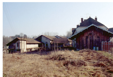
Vue d'ensemble depuis l'ouest. De gauche à droite : transformateur, atelier de fabrication, logement et remise à automobile. Au premier plan, aire des produits manufacturés. Phot. Jérôme Mongreville IVR43_19963900059ZA
