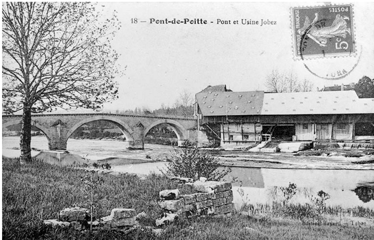
Pont-de-Poitte - Pont et Usine Jobez.
