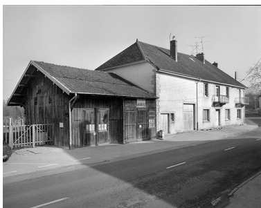
Remise à automobile et logement. Phot. Jérôme Mongreville IVR43_19963900057X
