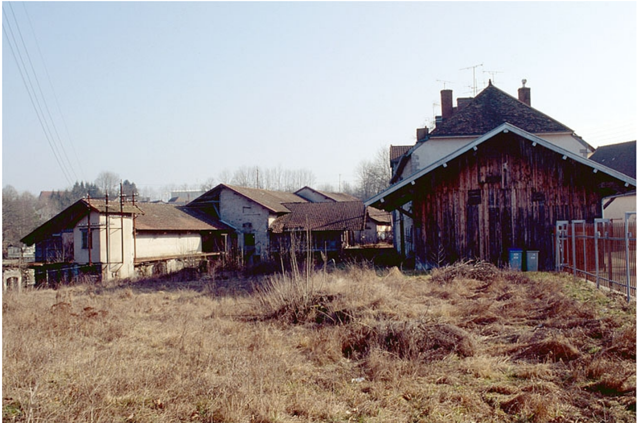
Vue d'ensemble depuis l'ouest. De gauche à droite : transformateur, atelier de fabrication, logement et remise à automobile. Au premier plan, aire des produits manufacturés.
