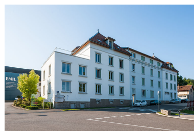
École nationale d'industrie laitière (ENIL) de Mamirolle. Phot. Jérôme Mongreville IVR43_20132501581NUC4A
