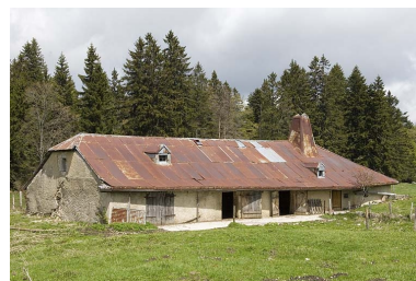
Chalet d'estive de la Bécasse, à Jougne. Phot. Jérôme Mongreville IVR43_20092500815NUC2A
