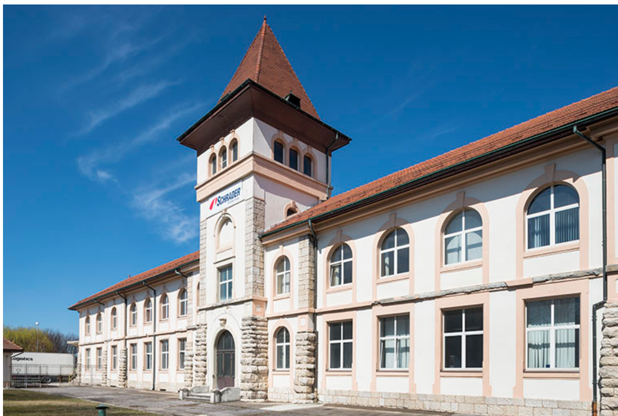
Usine de petite métallurgie Schrader, à Pontarlier.
