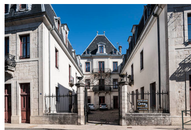
Distillerie Cusenier, 9-11 rue Eugène Cusenier, à Ornans.
