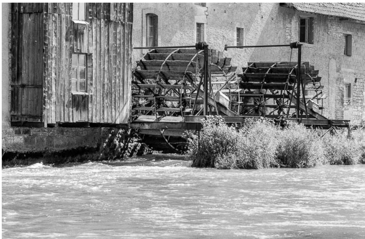
Roues hydrauliques suspenduee sur la Loue, à Ornans.
