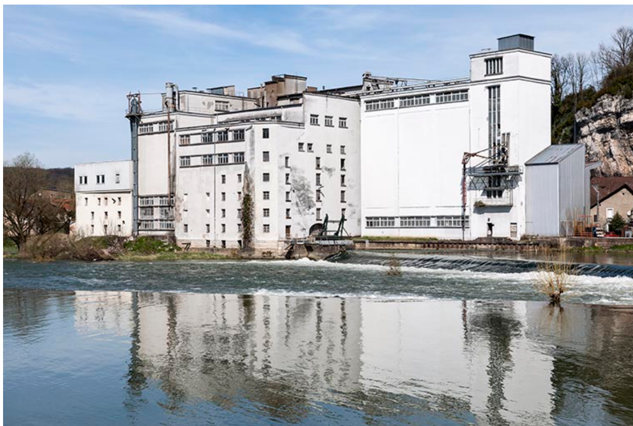
Minoterie et usine d'aliments pour le bétail à Avanne.
