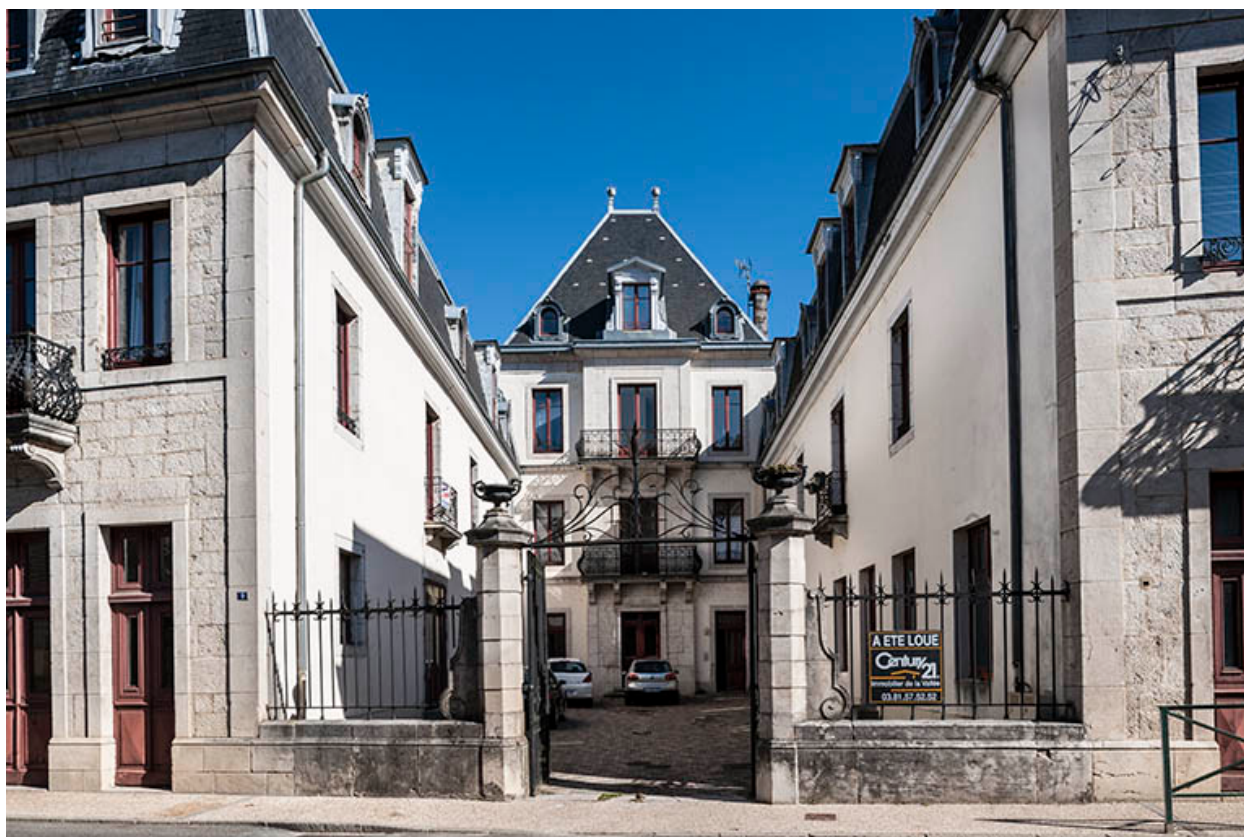
Distillerie Cusenier, 9-11 rue Eugène Cusenier, à Ornans.
