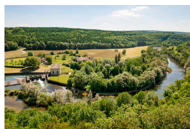
Forges (tréfilerie et clouterie) puis centrale hydroélectrique de Châtillon-sur-Lison. Phot. Jérôme Mongreville IVR43_20152501225NUC4A
