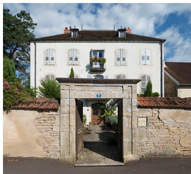
La façade antérieure et le portail d'entrée. Phot. Jérôme Mongreville IVR43_20187000308NUC4A
