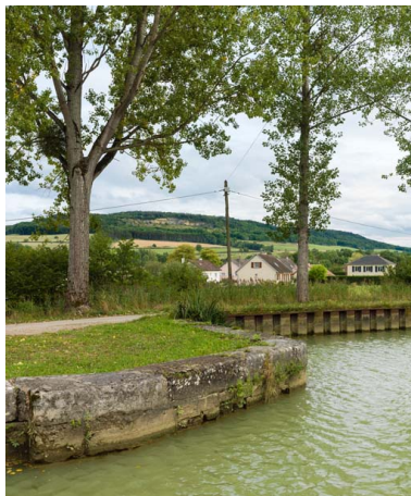
Vue des carrières depuis le canal. Phot. Pierre-Marie Barbe-Richaud IVR26_20172100566NUC2A
