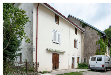
Bâtiment de 1723 : façade antérieure, de trois quarts. Phot. Sonia Dourlot IVR43_20192501190NUC4A
