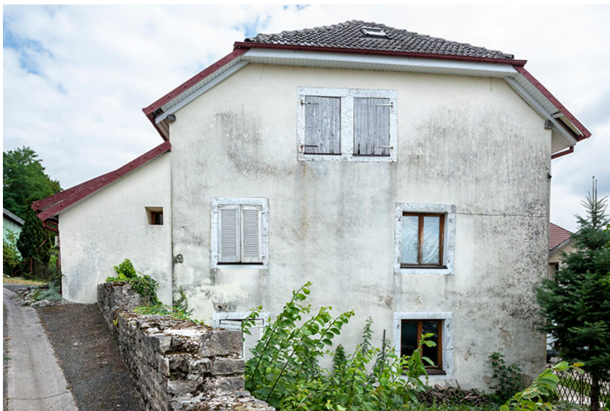
Bâtiment de 1723 : façade latérale gauche.
