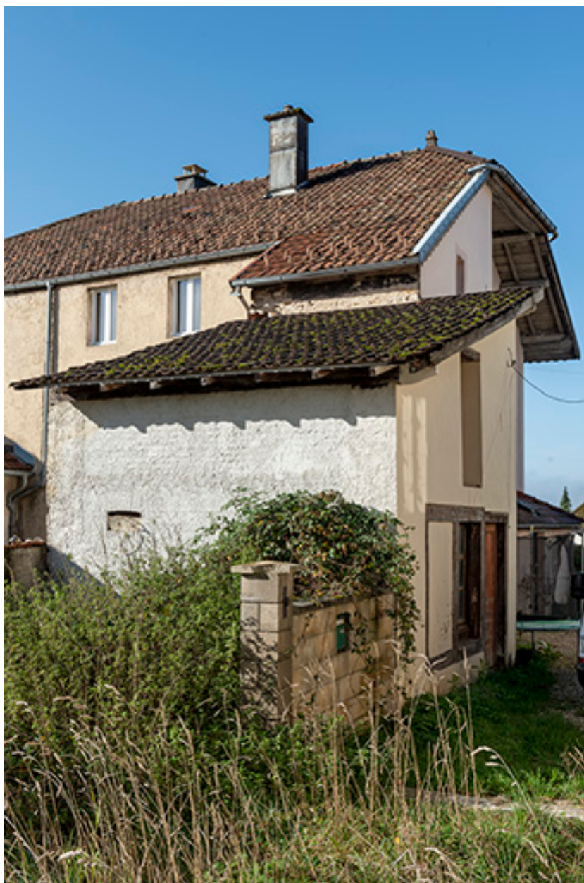
Atelier de fabrication, de trois quarts gauche.
