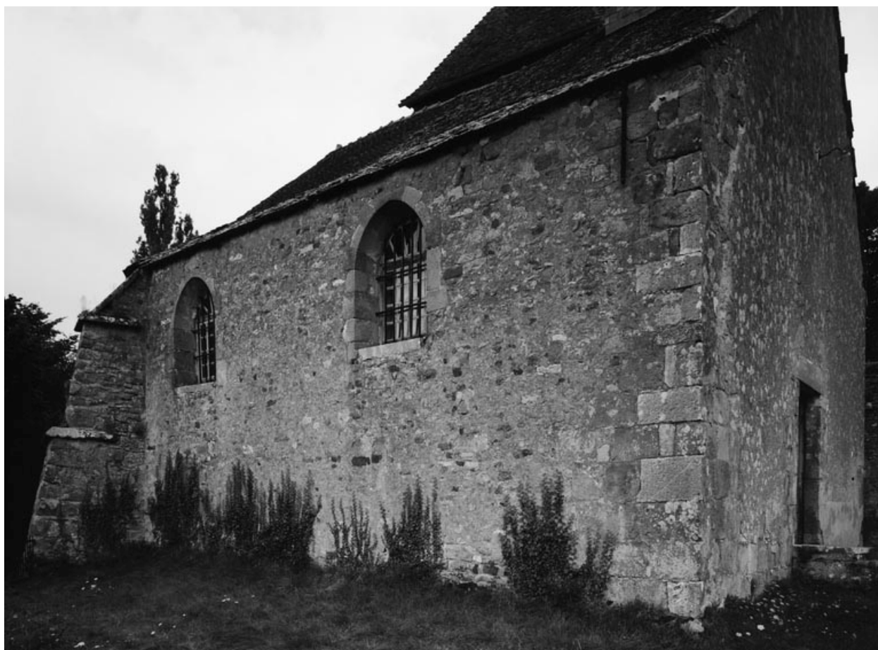
Elévation droite (photo prise en 1978).
