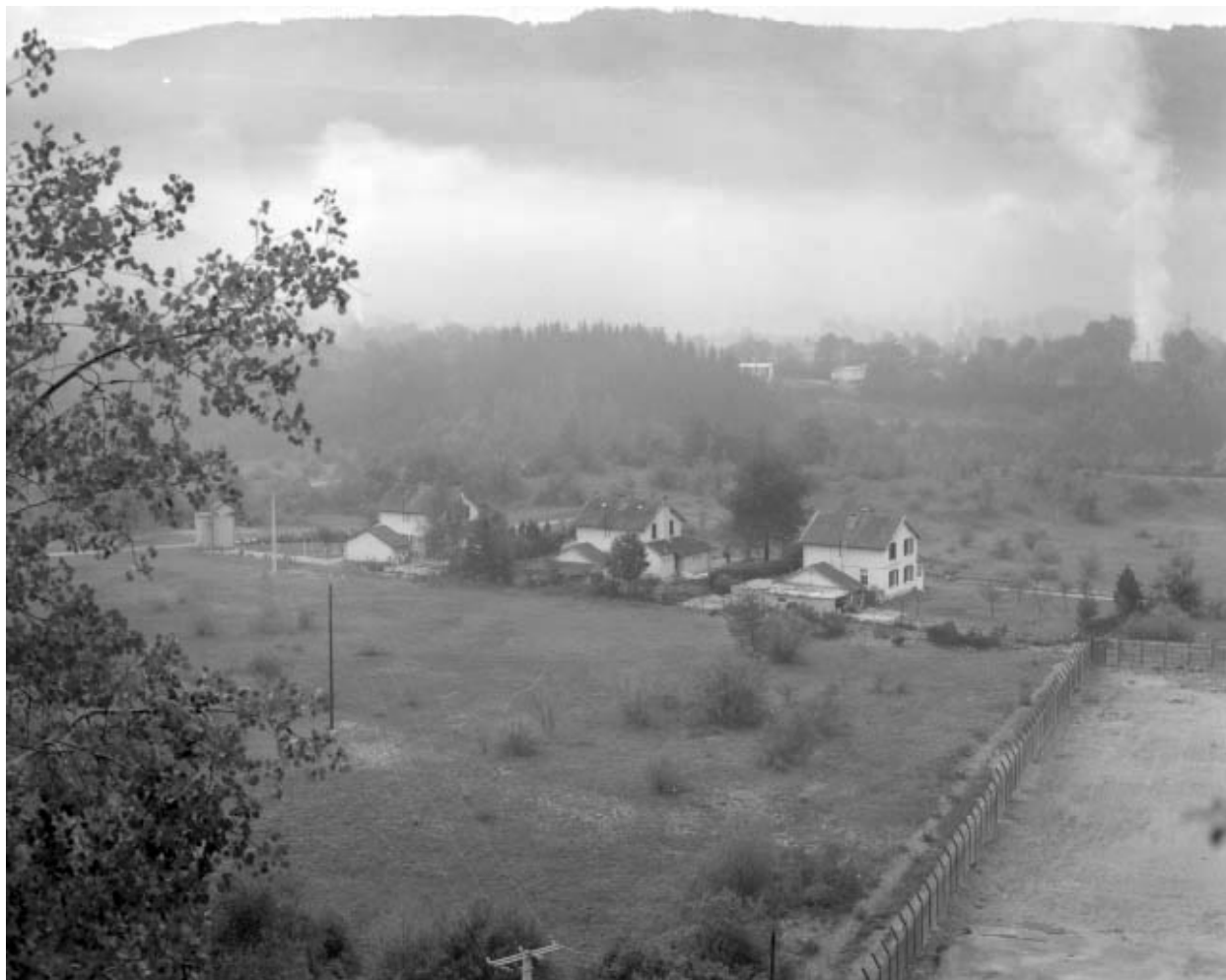
Vue d'ensemble des trois maisons.
