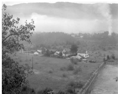
Vue d'ensemble des trois maisons. Phot. Jérôme Mongreville IVR43_19913900700X
