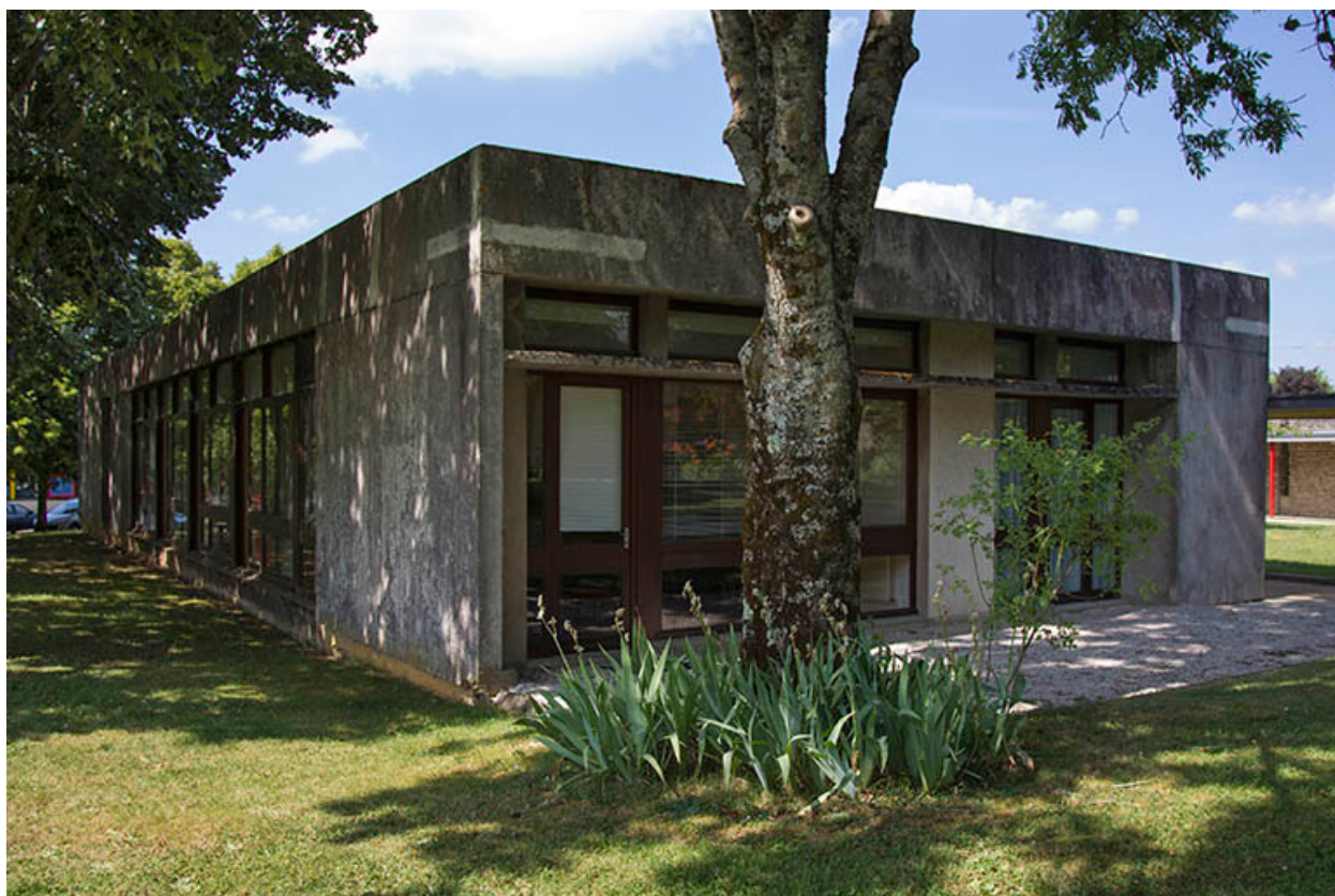
Angle sud-ouest de l'administration.
