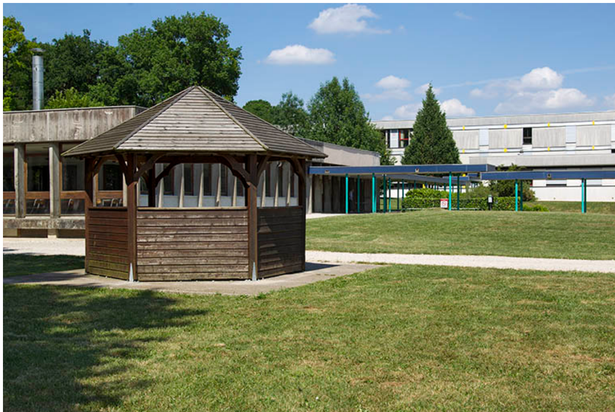
Kiosque à l'angle sud-ouest de la cantine.
