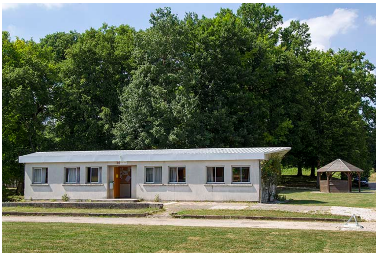
Façade sud des salles des classes préparatoires.
