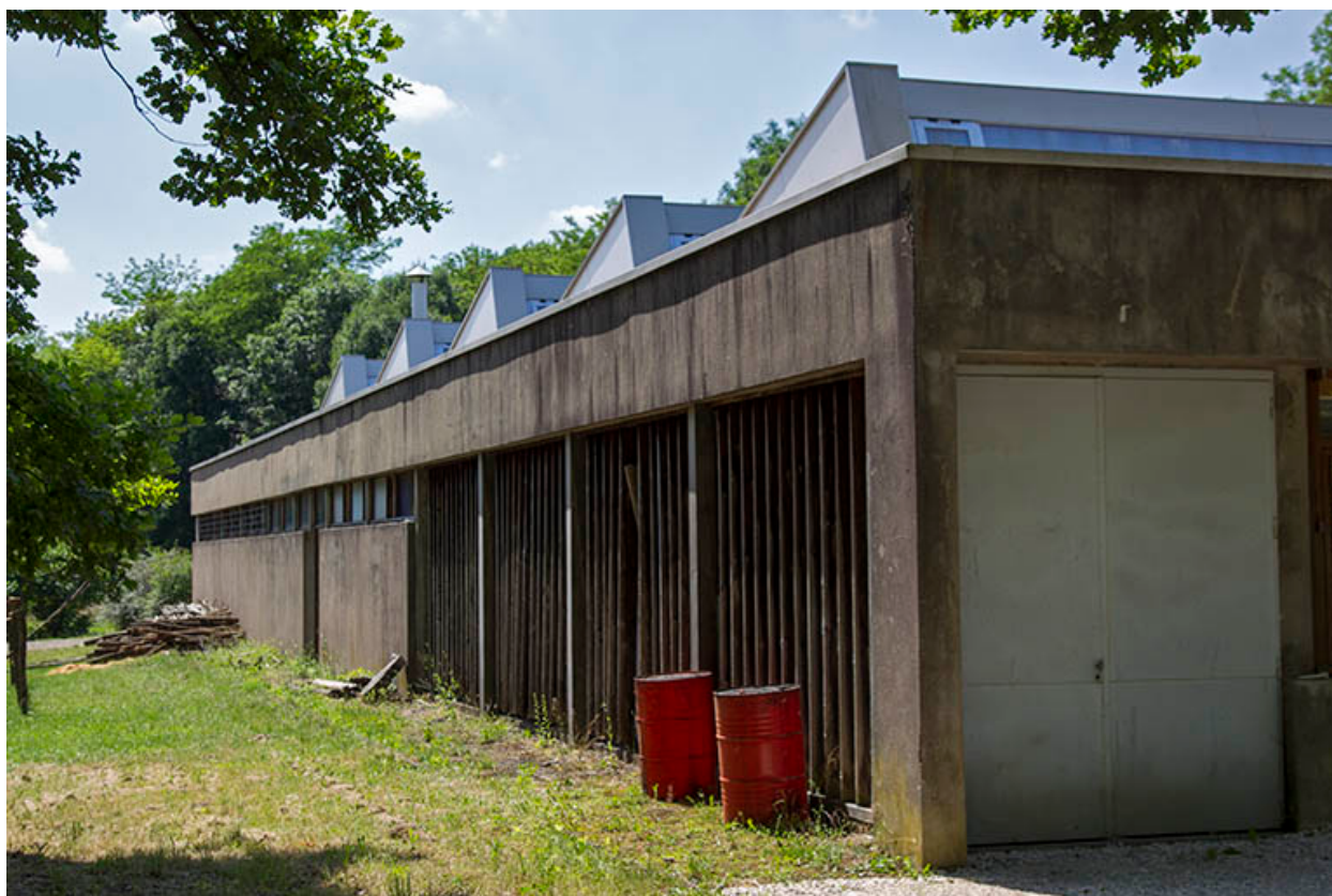
Angle sud-est de l'atelier.
