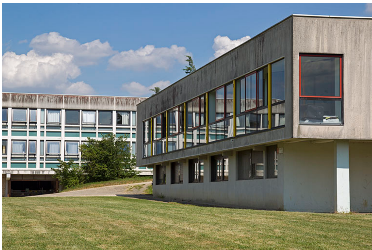
Angle nord-ouest du bâtiment d'internat de filles.
