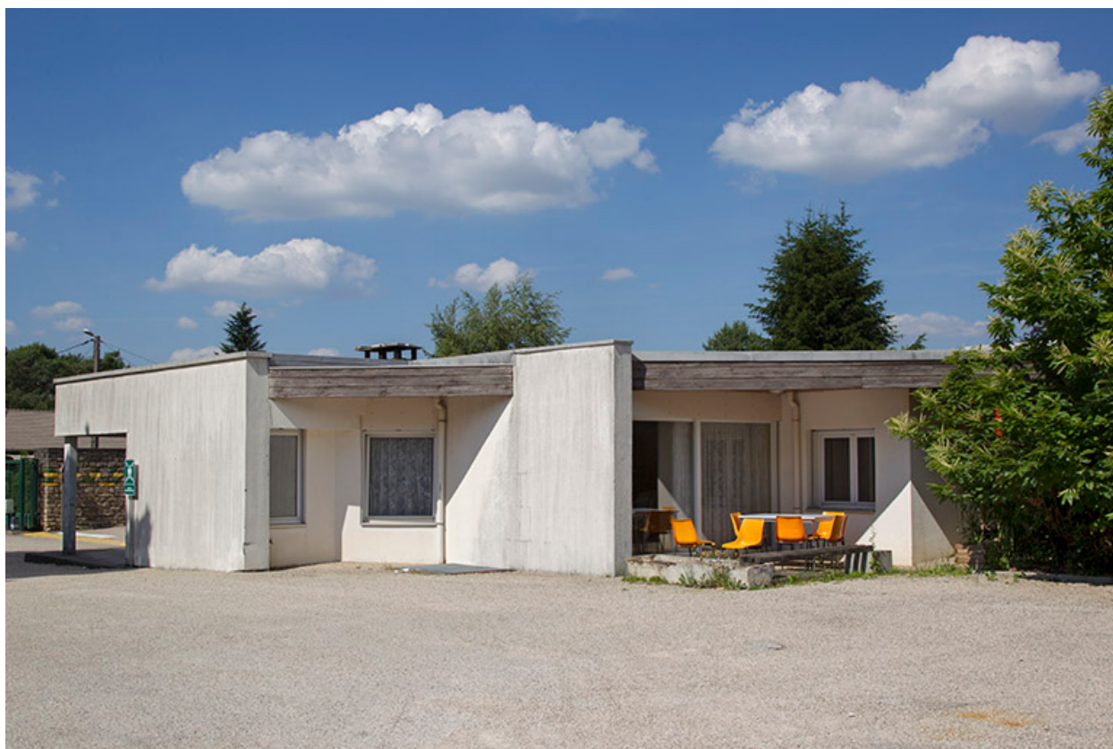
Façade postérieure ouest de la loge.
