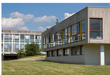
Angle nord-ouest du bâtiment d'internat de filles.
