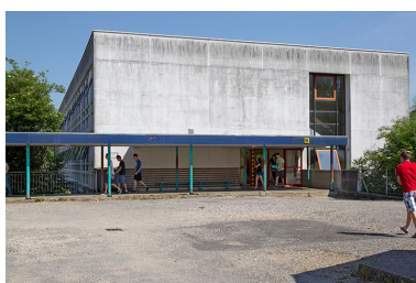
Pignon sud de l'externat. Phot. Sonia Dourlot IVR43_20142500935NUC2A
