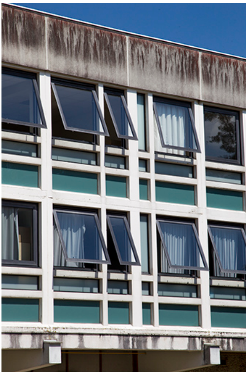
Détail de façade postérieure - ouest - de l'externat.
