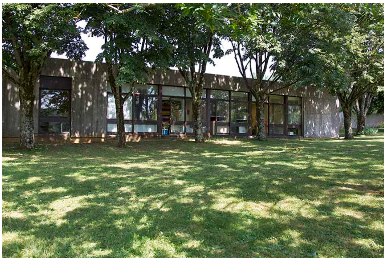
Façade postérieure - ouest - de l'administration.
