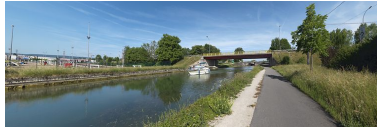
Le pont dans son environnement. Phot. Thierry Kuntz IVR26_20112103000NUC4A
