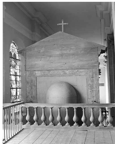
Partie supérieure du revers du retable sud. Phot. Yves Sancey IVR43_20003900574X
