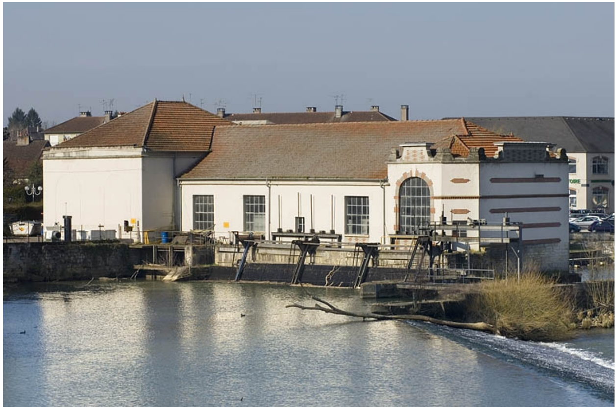
La centrale hydroélectrique vue de trois quarts.
