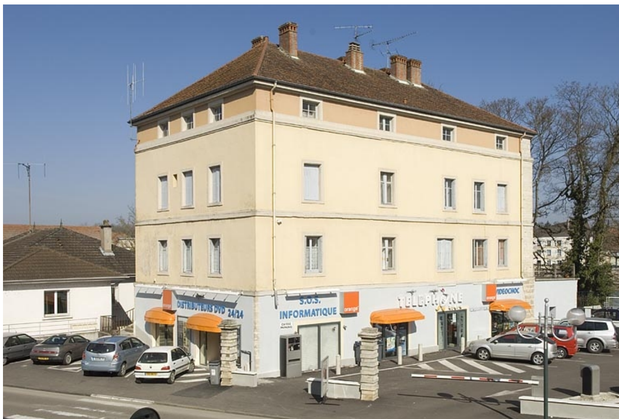
Bâtiment des logements et bureaux.
