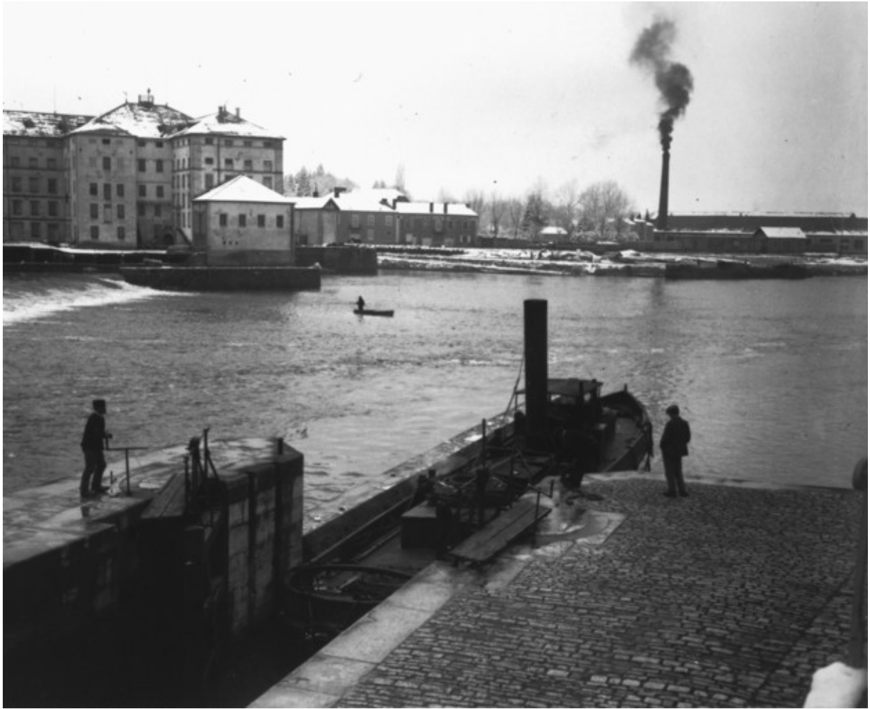
Les Grands Moulins de Gray vus depuis l'écluse.
