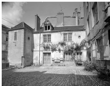
Aile gauche sur cour. Phot. Yves Sancey IVR43_19897000423V
