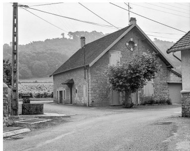
Façades latérales antérieure et droite.
