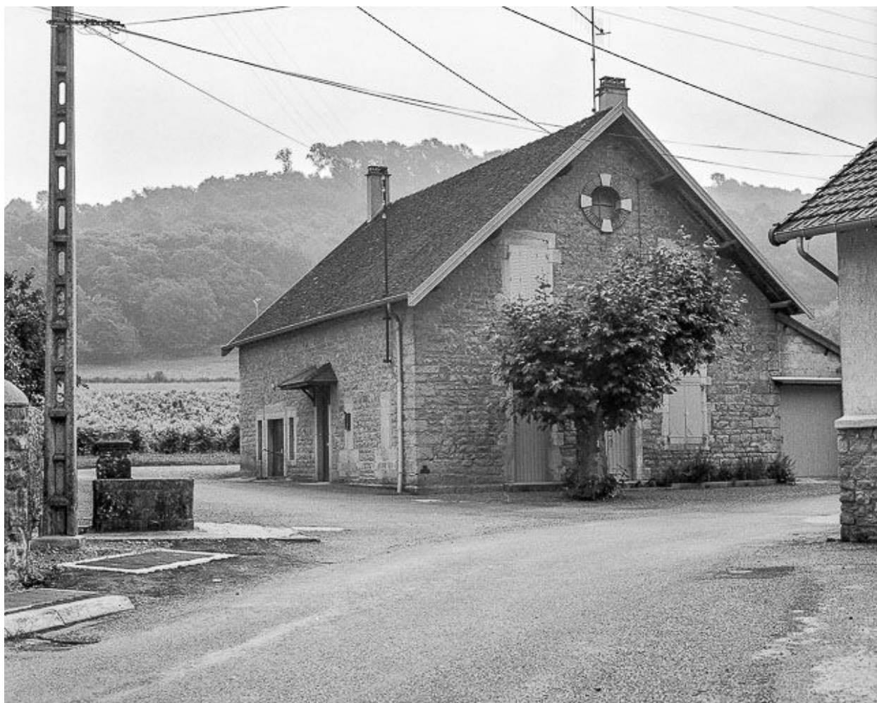
Façades latérales antérieure et droite.
