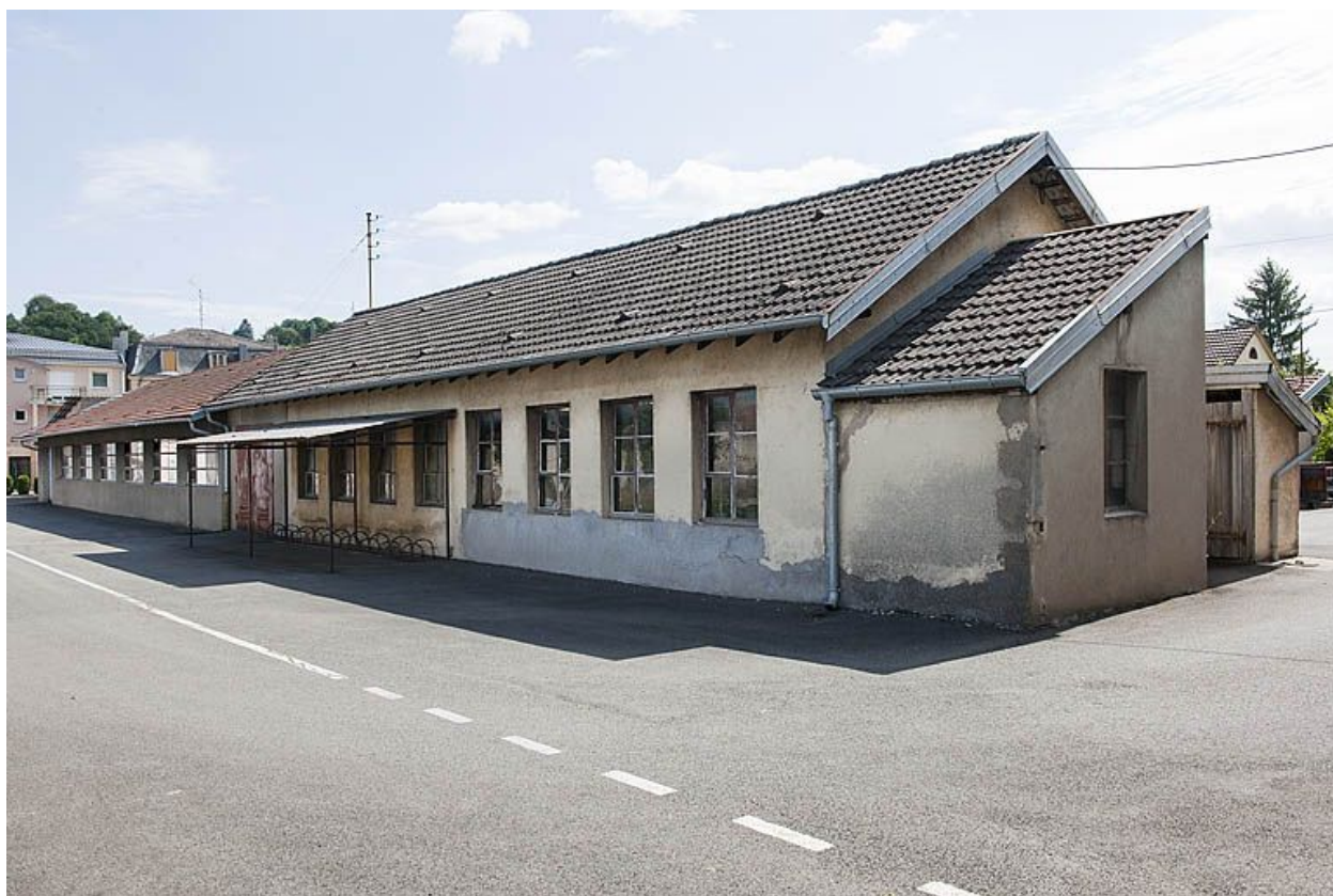
Façade ouest de deux ateliers de décolletage.
