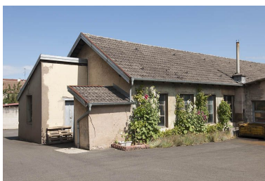
Atelier de décolletage sud. Phot. Jérôme Mongreville IVR43_20112501463NUC4A
