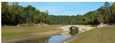
Vue du pont.
