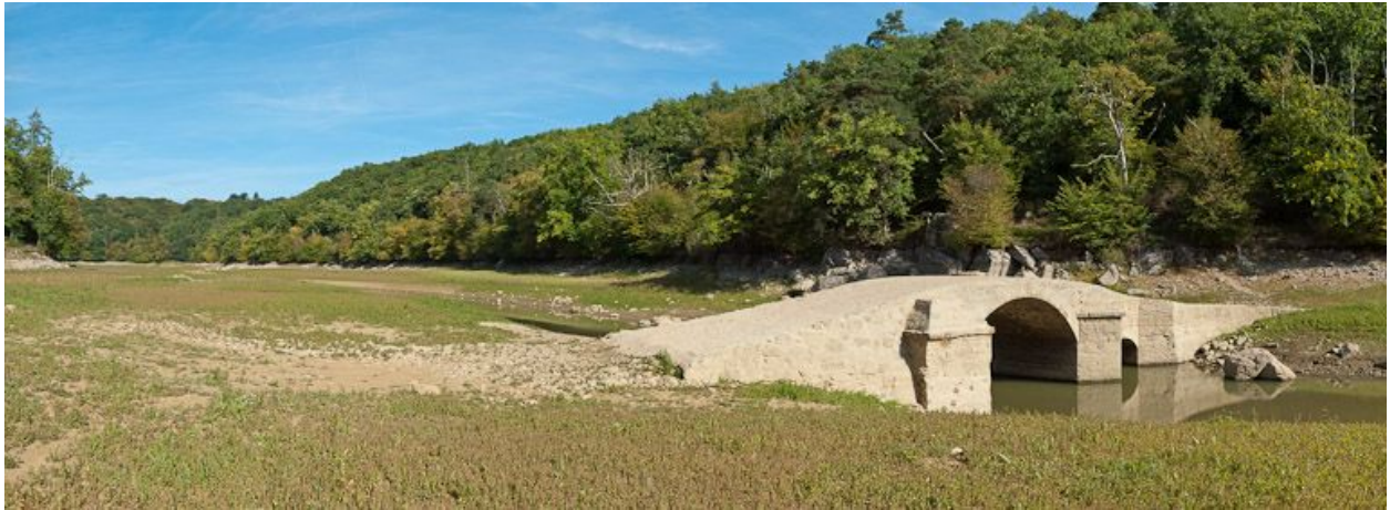
Vue du pont.
