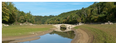
Vue du pont.
