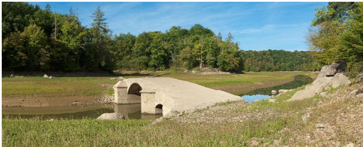
Vue du pont.
