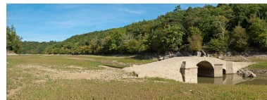
Vue du pont.
