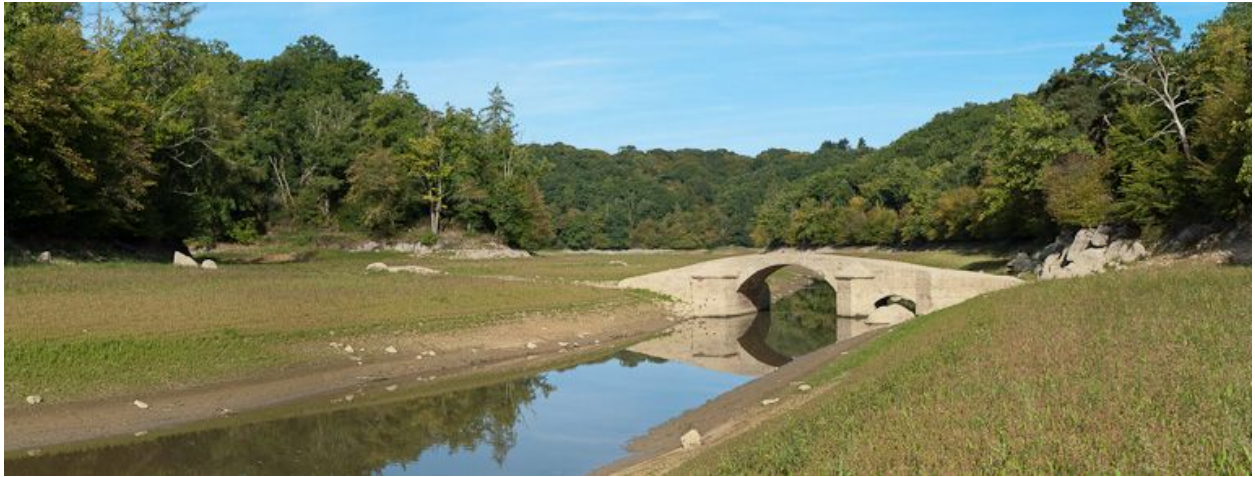
Vue du pont.
