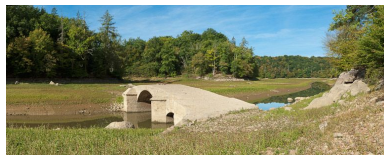
Vue du pont.
