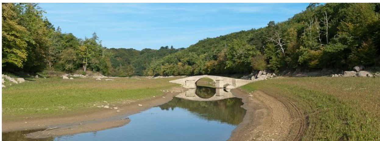
Vue du pont.
