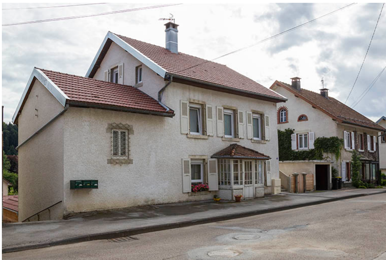
Façades antérieure et latérale gauche.
