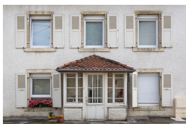
Façades antérieure. Phot. Yves Sancey IVR43_20132501868NUC2A
