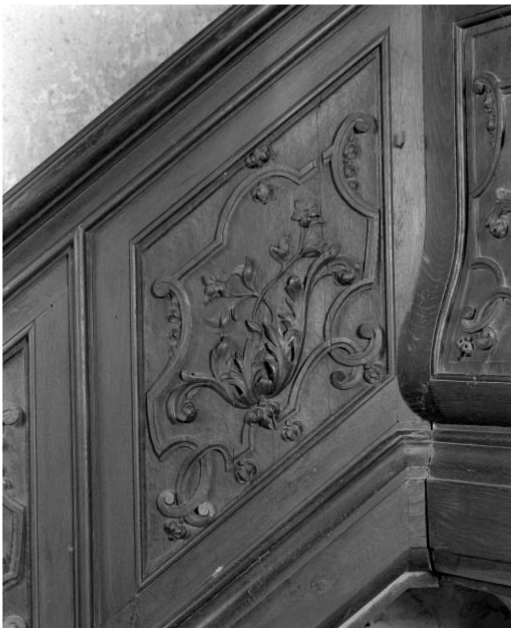
Détail de l'escalier
