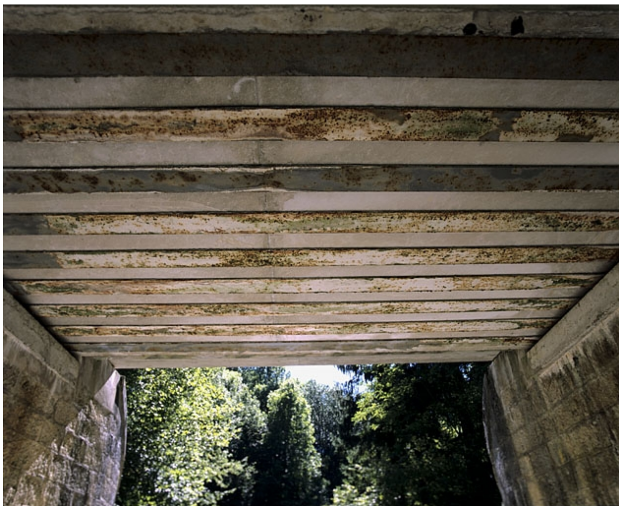
Pont : poutrelles en face inférieure du tablier.
