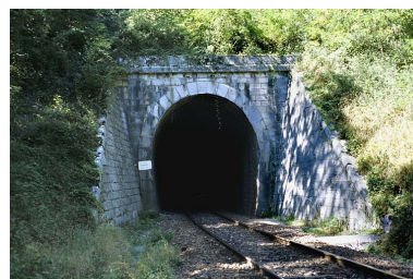
Tunnel d'Arbent 1 : tête côté La Cluse (sud-est).
