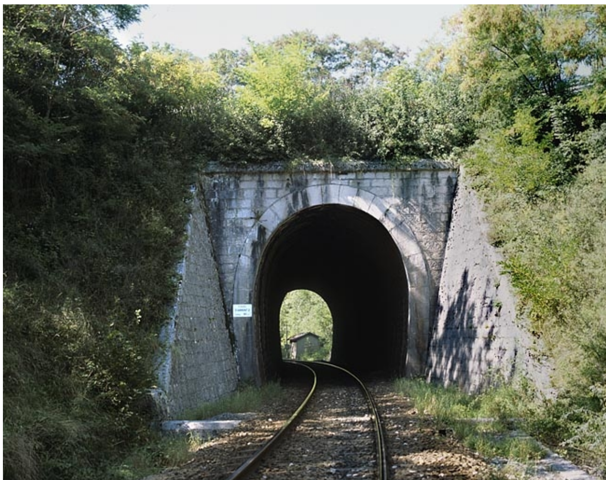
Tunnel d'Arbent 2 : tête côté La Cluse (est).
