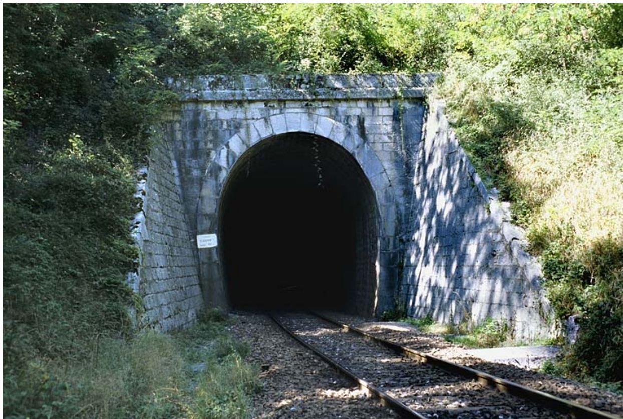
Tunnel d'Arbent 1 : tête côté La Cluse (sud-est).
