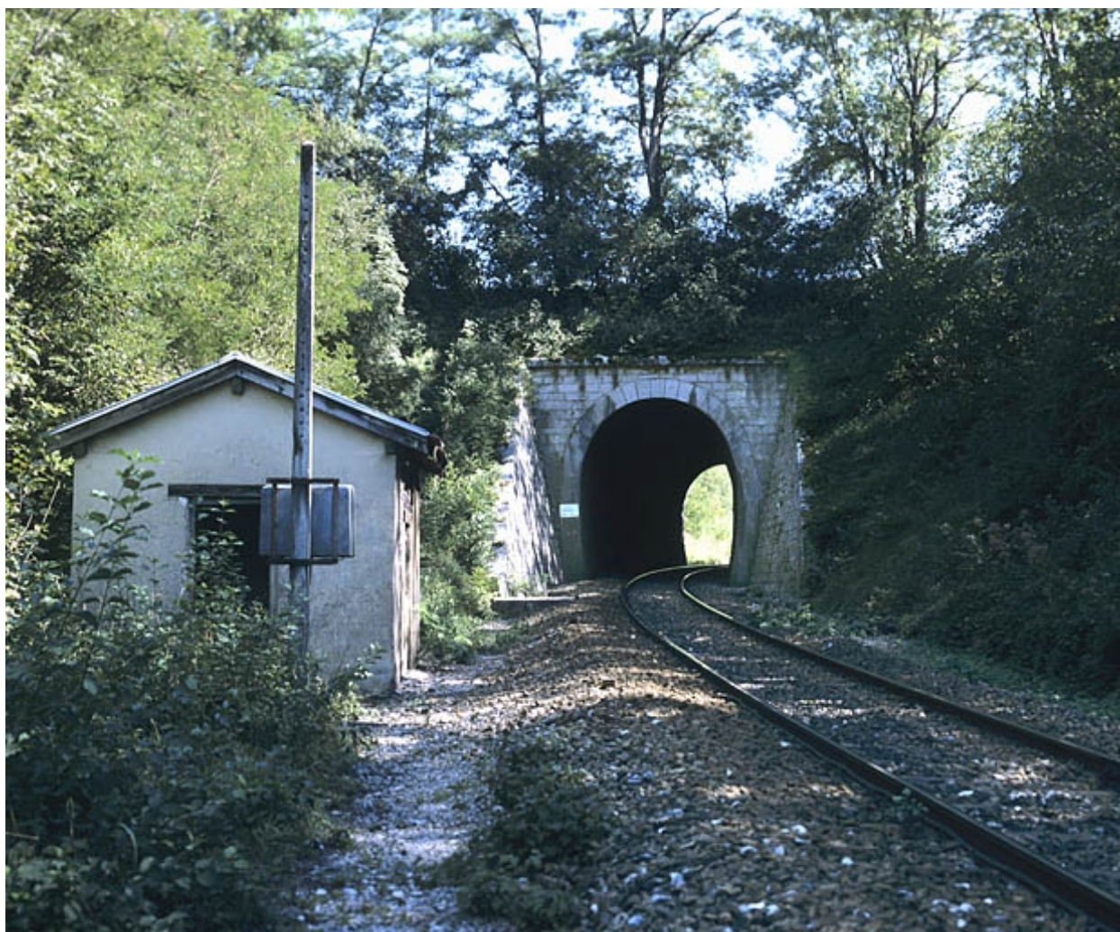
Tunnel d'Arbent 2 : tête côté Andelot-en-Montagne (ouest).
