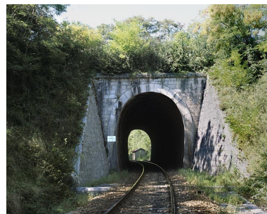
Tunnel d'Arbent 2 : tête côté La Cluse (est). Phot. Yves Sancey IVR43_20050100065XA
