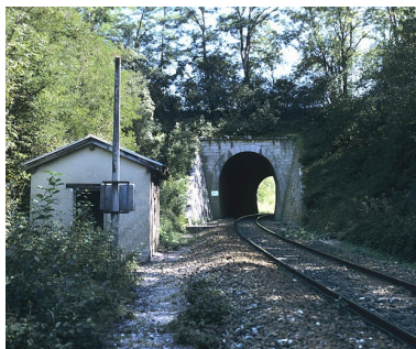
Tunnel d'Arbent 2 : tête côté Andelot-en-Montagne (ouest). Phot. Yves Sancey IVR43_20050100063XA
