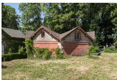
Vue depuis le sud-sud-est. Phot. Pierre-Marie Barbe-Richaud IVR26_20195800380NUC4A
