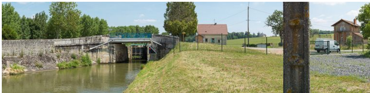
Le pont, vu d'aval.
