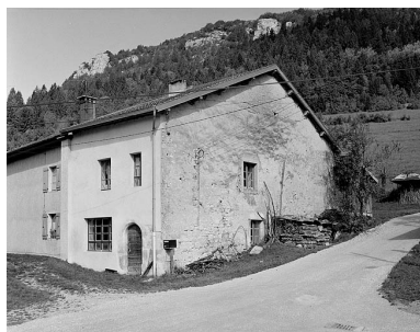
Prévôté, ferme rue du Four. Phot. Jérôme Mongreville IVR43_19943901099X
