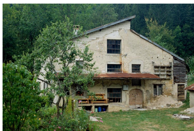
Ferme, minoterie au lieu-dit au Closet. Phot. Laurent Poupard IVR43_19903901234ZA
