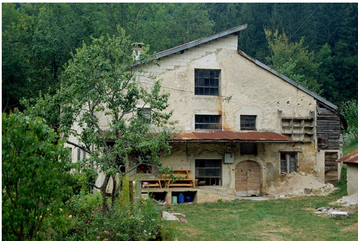
Ferme, minoterie au lieu-dit au Closet.
